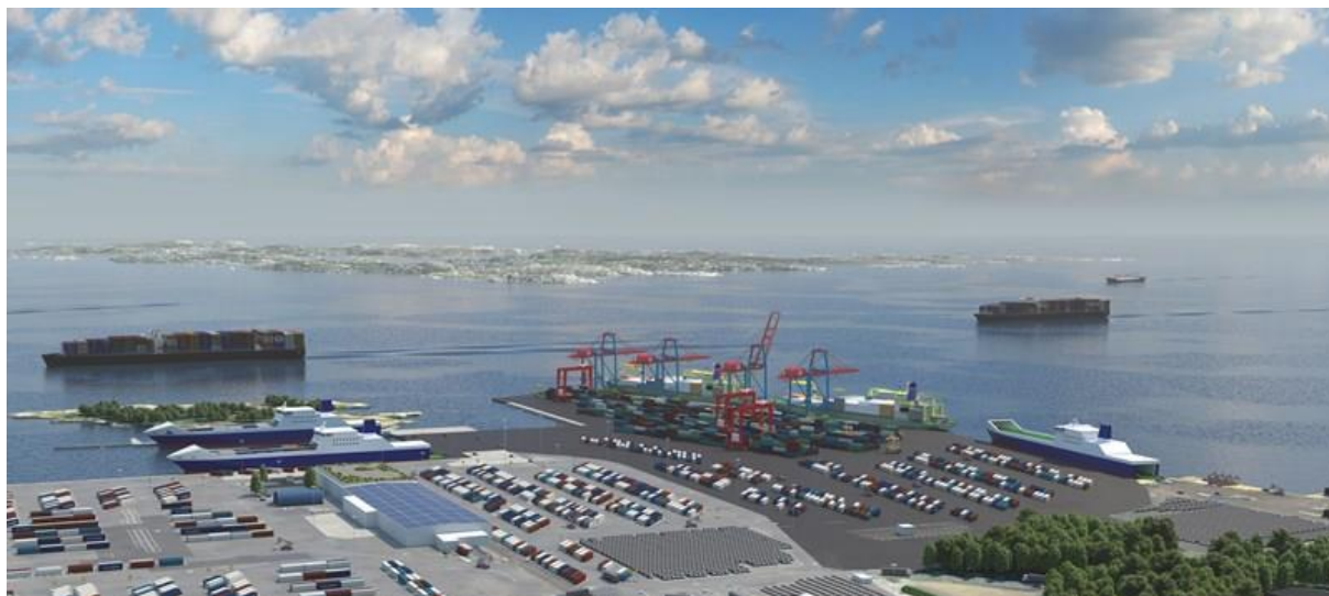
Figur 21. Älvsborgshamnens planlagda expansion. Det intressanta med denna bild är vad den inte visar. På den befintliga vattenytan mellan Älvsborgshamnen och Arendalshamnen som ska bebyggas enligt bilden finns fortfarande Lilla Aspholmen som kommer plansprängas och integreras i den nya hamnanläggningen. Lilla Aspholmen har tillsammans med Stora Aspholmen viktiga funktioner för riksintresset Älvsborgs fästning som är beläget strax till vänster utanför bilden.
