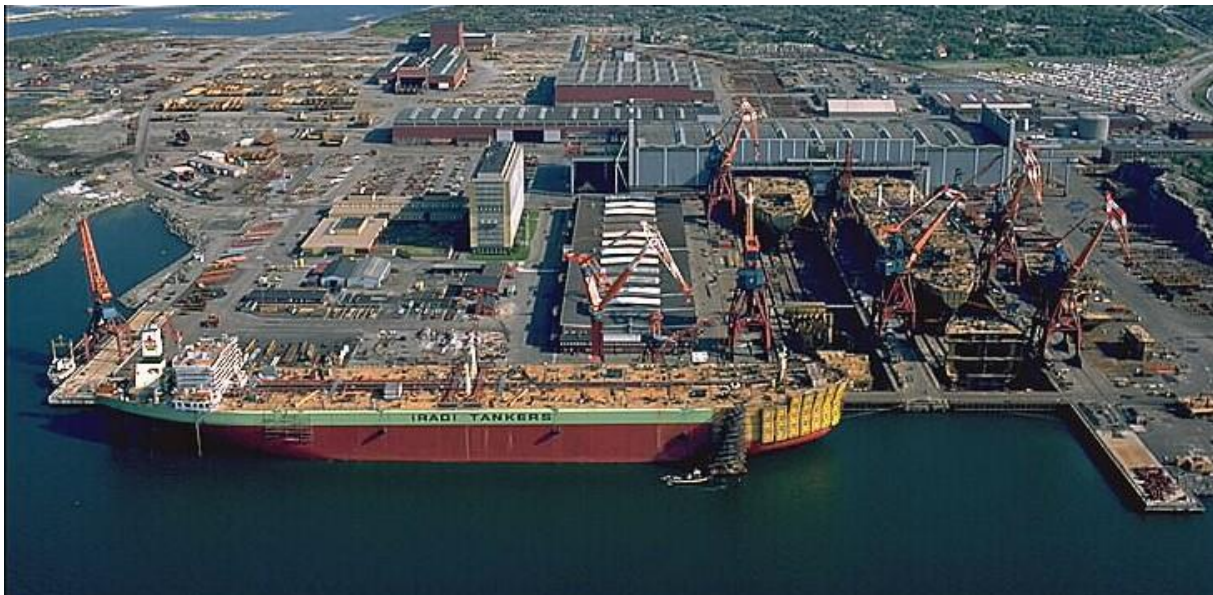
Figur 13. Arendsvarvet 1977. Fartygen fogades ihop inomhus i skrovhallen och sköts därefter ut i utrustningsdockorna närmast vattnet som på ett löpande band. Till vänster framför skrovhallen ligger utrustningsverkstaden och huvudkontoret som på denna bild nyligen byggts på från 6 till 12 våningar. Riksantikvarieämbetet.
