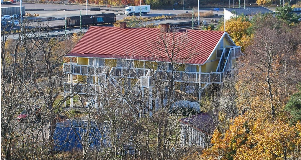
Figur 22. Arendals stamgård sedd från Ardalsberget. Arendals stamgård med anor från 1700-talets slut fungerade bland annat som gästgiveri och skjutshåll då Älvsborgs fästning fortfarande var i bruk. Sedan 2004 har fastigheten kraftigt byggts om och har bland annat använts som missbrukarboende.
