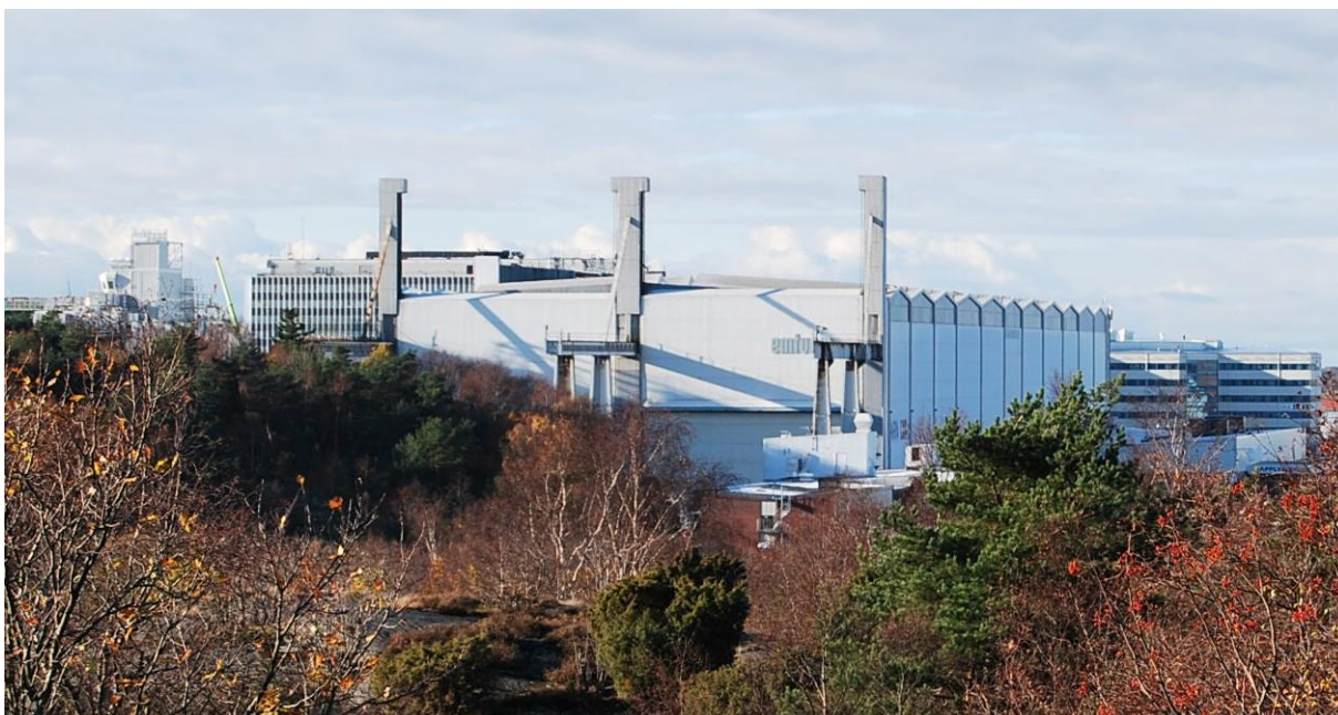
Figur 19. Skrovhallen vid Arendalsvarvet uppförd 1962 sedd från Ardalsberget. Den monumentala byggnaden var Arendalsvarvets hjärta. Nu används den av företaget Apply Emtunga som bygger olika typer av modullösningar till Offshoreindustrin. Till vänster i bakgrunden syns Arendalsvarvets forna huvudkontor som nu används av ett flertal företag inom Volvokoncernen.
