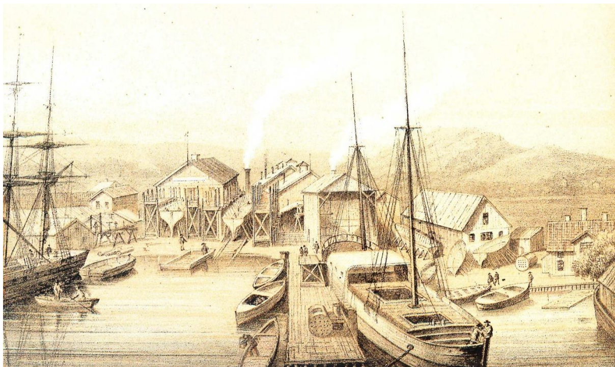
Figur 3. Varvet på norra älvstranden under 1870-talet. Keillers tomt på Hisingen var ca tvåhundra m bred mot älvstranden. Det första som flyttades över älven till Hisingssidan var varvsverksamheten. På bilden syns de första två mindre fartygssliparna. De större byggnaderna bakom dessa innehöll plåtslageri och en järnvägsvagnsverkstad. Till höger ligger magasinsbyggnader och ett varvskontor. Området låg mer eller minder på en halvö i vassen som byggt upp av muddermassor från älven. Bryggor har anlagts, men ännu inga kajer. 79
