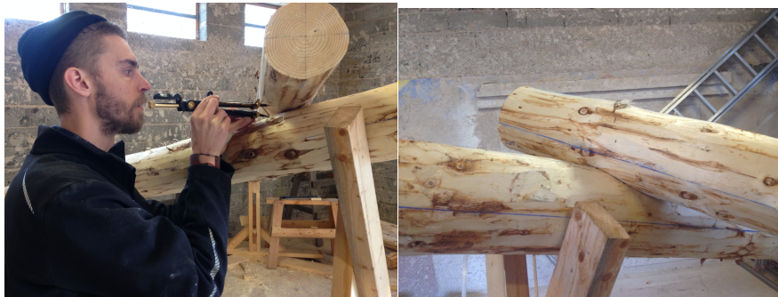
Figur 25 & 26 Urtaget märks ut med våg- och lodinställbar passare och kopierar då underliggande stocks form Foton: Torbjörn Einarsson
