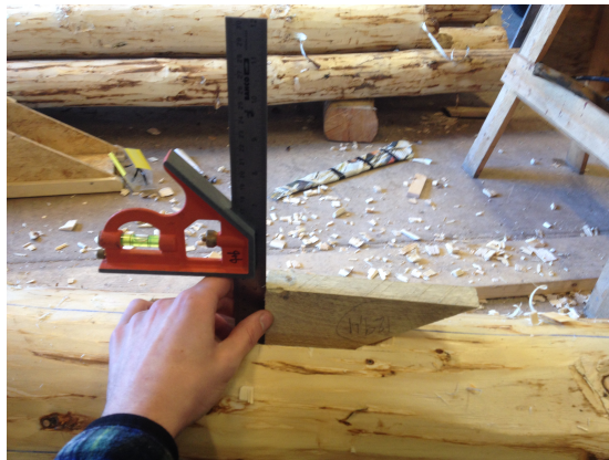
Figur 20 Genom att hålla vinkelmallen i lod kan tapphållets vinkel kontrolleras Foto: Torbjörn Einarsson
