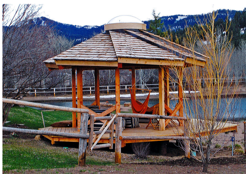
Figur 35 Lusthus med reciprokt tak där man använt sig av trappstegslösning med kupol Foto: Adam Riley
