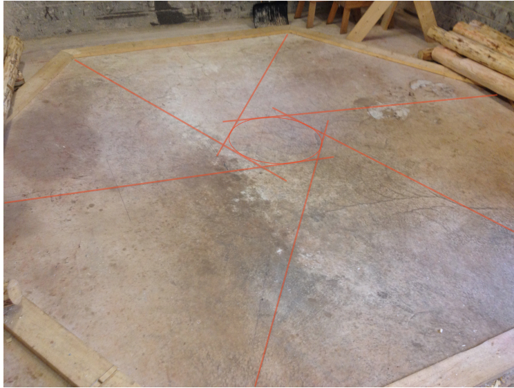
Figur 15 Utslagning i full skala på golvet med cirkeln i mitten där sparrarnas systemlinjer tangerar. Linjerna är rödmarkerade i för att synas bättre i figuren. Foto: Torbjörn Einarsson
