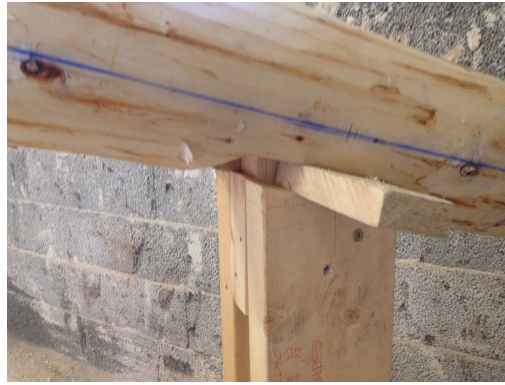
Figur 24 Sparrens bas måste höjas upp lika mycket som toppen ska fällas ner vid påritningen Foto: Torbjörn Einarsson
