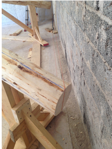
Figur 33 Murarsnötet spänns upp mellan de båda övre och de båda undre systemlinjerna Foto: Torbjörn Einarsson
