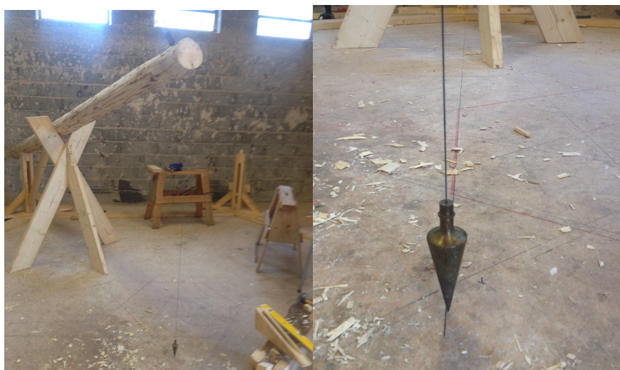
Figur 22 & 23 Sparrens vägs in med sänklod emot utslagningen på golvet, genom att ha sänklodet så nära golvet som möjligt tillåts väldigt små toleranser Foto: Torbjörn Einarsson
