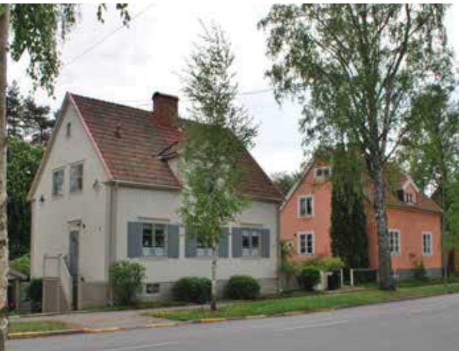
1920-tals klassicistiska hus i Smedslätten med visst inslag av nationalromantik. Blandning av stående träpanelfasader och fasader i puts.
