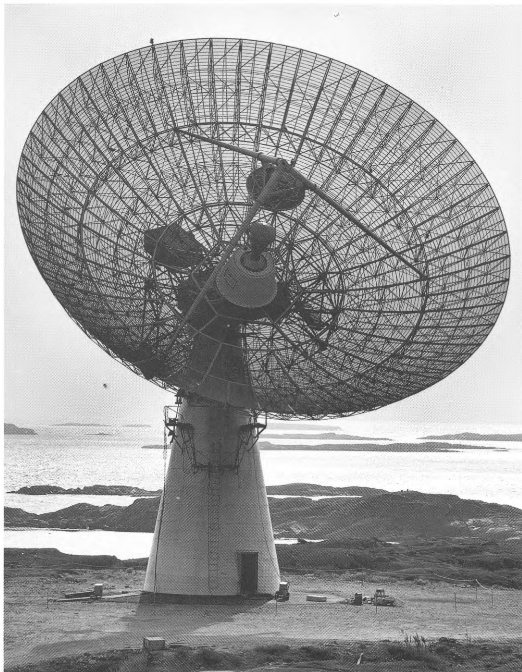
Det nya radioteleskopet sett i sydvästlig riktning mot bakgrund av Fjärehals skär. En skönhet på rätt plats; en oförglömlig bild. Foto: Televerkets Fotokontor.
