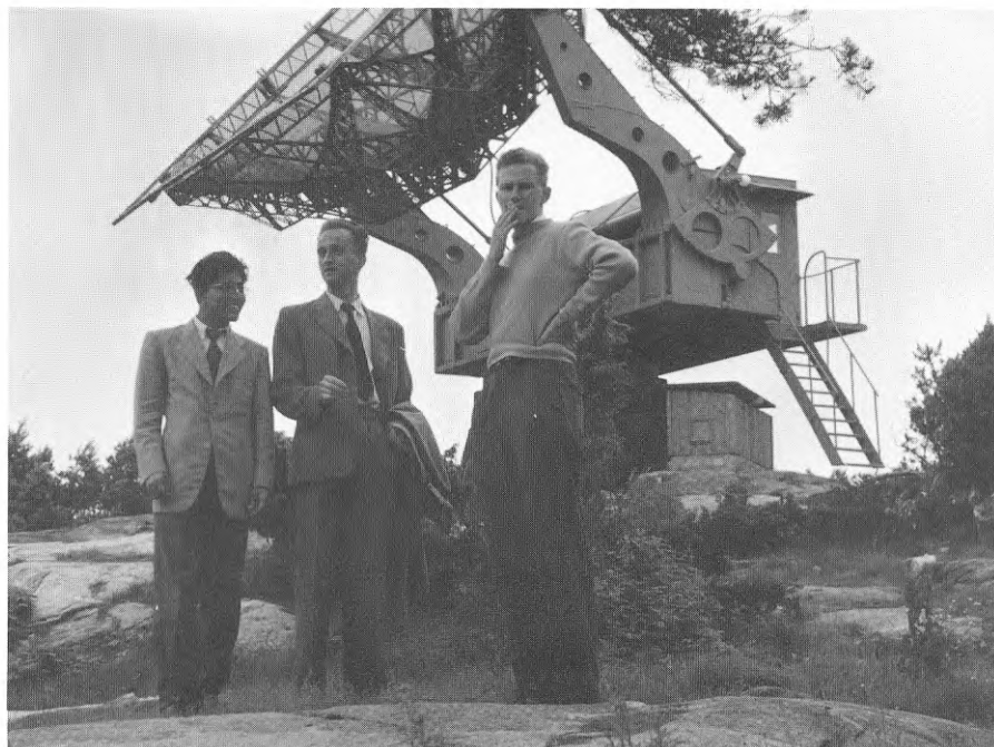
Herrar G.H. Joshi (sedermera licentiat i elektronik), Sverre Eng och Sven Olving tar igen sig mot bakgrunden av Würzburg nr 5. I lådan under teleskopkabinen en roterande synkron-synkron-omformare, en pålitlig strömkälla för teleskopet.
