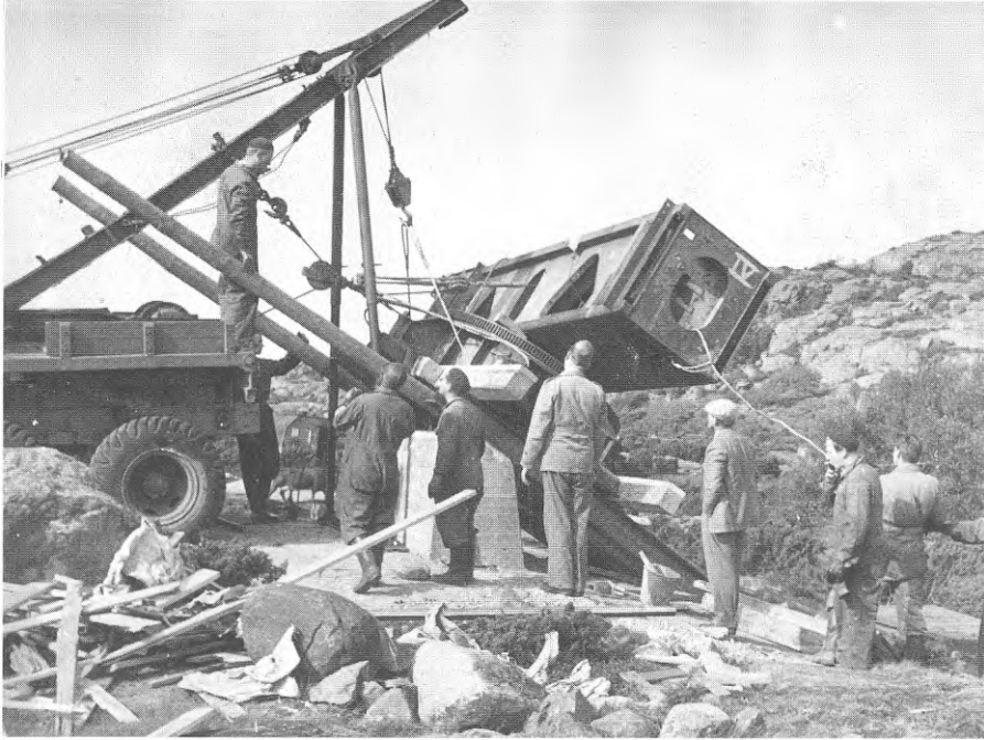
Pjäs A:s (Würzburg nr 1) kuggkrans och huvudbalk under uppspelning på Råö-fundamentet, med hjälp av KA 4 och dess kranbil. KA 4 hjälpte oss med hela transporten till Råö, som en fältmässig övning. Med huvudet på sned, stående nära balken, författaren, t v om honom vår verkstadschef Bror Baunge i baskermössa.
