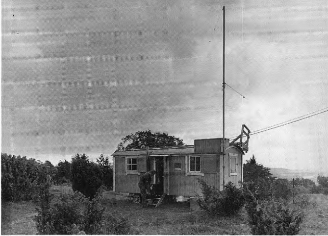
Mobil fältstation för radarvågutbredningsförsök i Hisings Kärra på 10.3 och 1 cm våglängd. Sändarna monterades i en särskild barack på Mosseberg, Södra Guldheden, (där det nu finns bostadshus). Första försöken av sin art i Sverige, ca 1950.
