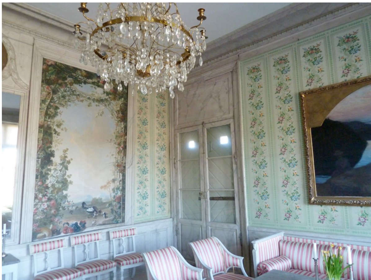
Fig. 14. Franska salongen. Originaltapeten syns till vänster och rekonstruktionen till höger i bilden.
