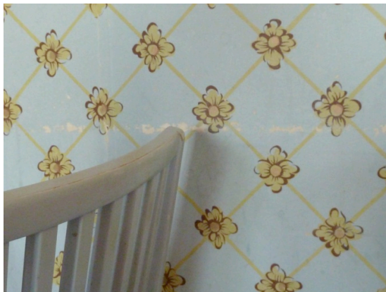
Fig. 23 & 24. Slitage på en av de rekonstruerade tapeterna från Handtryckta tapeter AB. Nyckelvikens III . Mekaniskt slitage från kaféinredningen till höger samt fuktfläckar till vänster.
