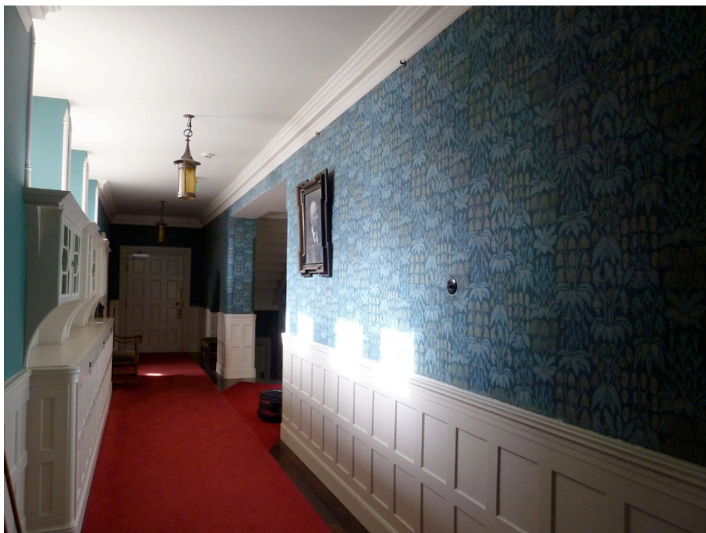
Fig. 29. På vänstra väggen finns en originaltapet i jugendstil. Ytterväggen är bemålad med en emulsionsfärg i samma ton som tapeten.
