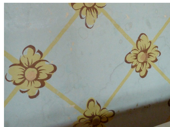
Fig. 23 & 24. Slitage på en av de rekonstruerade tapeterna från Handtryckta tapeter AB. Nyckelvikens III . Mekaniskt slitage från kaféinredningen till höger samt fuktfläckar till vänster.
