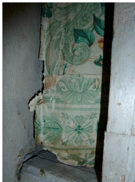
Fig. 19. Originaltapeten lossar delvis från underlaget med revor som följd. Ett pågående underhåll är viktigt.
