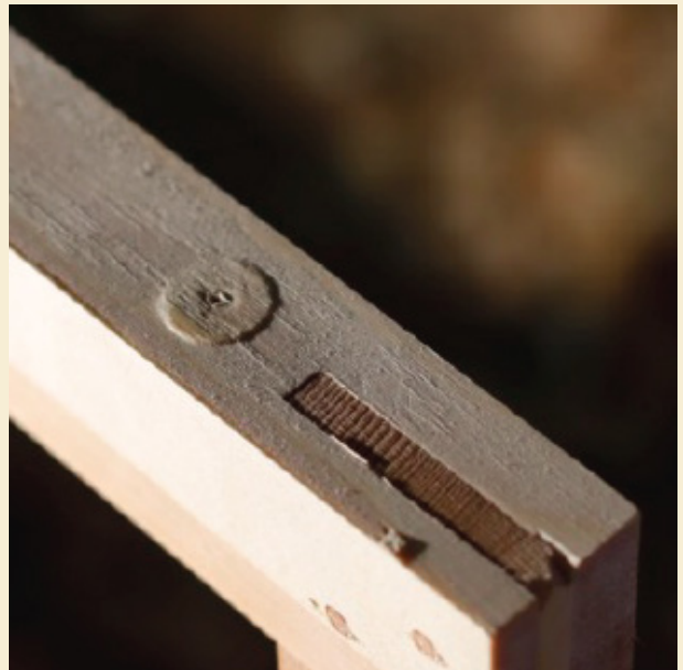
34. Efter att bågverket ställt in sig efter uteluftens högre fuktighet har veden svällt. I de partier där tvingskruvarna pressat samman fibrerna så att de inte nåddes av justeringshyvlingen har fibrerna svällt proportionellt sett mer jämfört med den omgivande veden varför denna del höjt sig upp och bildat ett ovanligt tryckspår. Efter Renmælmo 2012.
