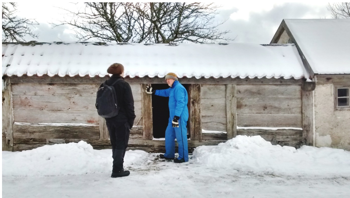
Figur 10. Bulhus är en gammal modell av trähus som var mycket vanlig på Gotland förr. Under 1800-talet vet man att många sådana hus putsades med kalkbruk, och för att få kalkbruket att fästa används man hasselkäppar som fästes vertikalt i ca 45 graders vinkel över träväggen. Detta berättar Stefan Haase (i blå overall på bilden) vid en intervju i hans hem i Lau Bjärge den 8 mars 2017 38 . Foto: Elina Ambjörnsson 8 mars 2017.
