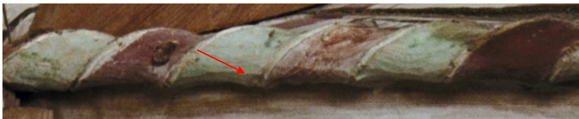
Figur 37. Verktygspår på repstav i Södra Råda. Foto: ATA, figur: Amanda Alskog
