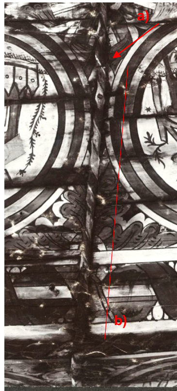
12. a) Stötfog, b) Kort skarvad bit. Foto: ATA, figurer: Amanda Alskog.
