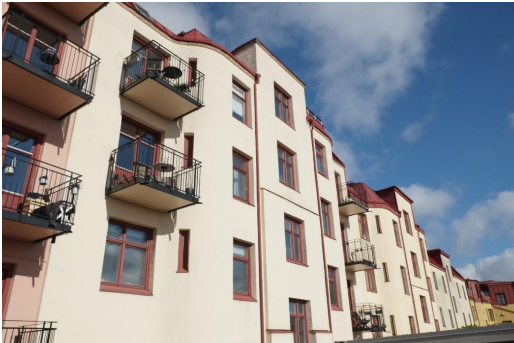
Fig. 13. Gårdsfasaden åt norr.
