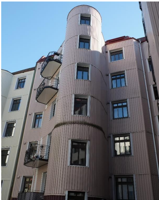
Fig. 6. Gårdsfasaden åt sydväst.
