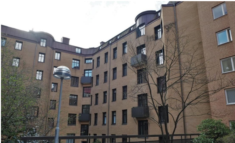
Fig. 10. Gårdsfasaden åt sydost.
