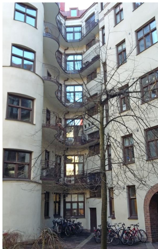
Fig. 17. Gårdsfasaden åt sydväst.
