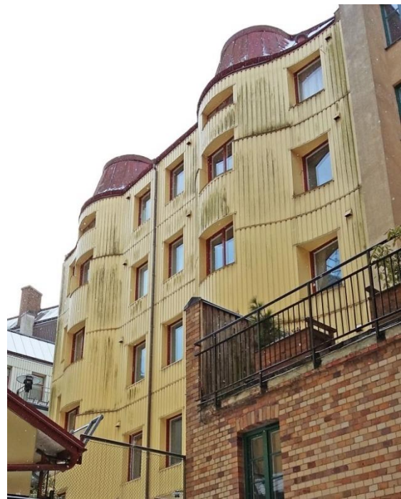
Fig. 3. Gårdsfasad tilläggsisolerad med korrugerad aluminiumplåt i Göteborg
