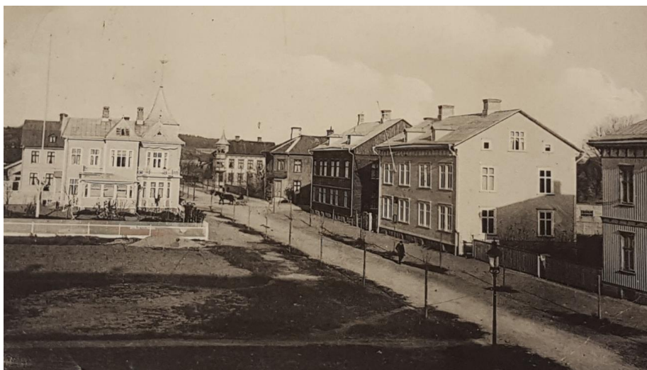
Fig. 4, 1907, nästan trettio år efter fastställandet av Wästfelts stadsplan, var fortfarande delar av de då planlagda kvarteren i staden obebyggda. På fotografiet ses kvarteret Järta och den norrutgående Alströmergatan.
