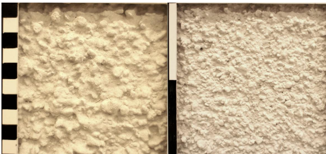
Fig. 28. Blandning 48 hårt påslag. Det hårda påslaget ger upphov till en puts där gruset framträder ur finbruket.
