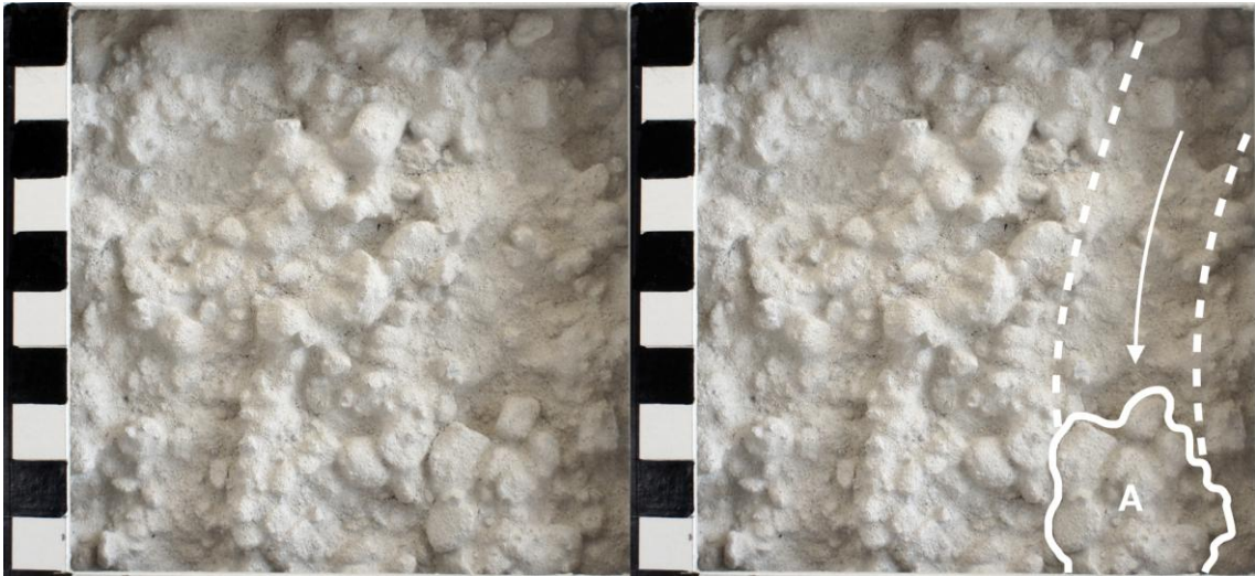
Fig. 16. Blandning 42c. På grund av den höga andelen vatten får detta bruk svårt att hänga kvar på väggen. Små sjok av bruk (likt den markerad A) glider ner utmed putsen och bildar spår efter sig.
