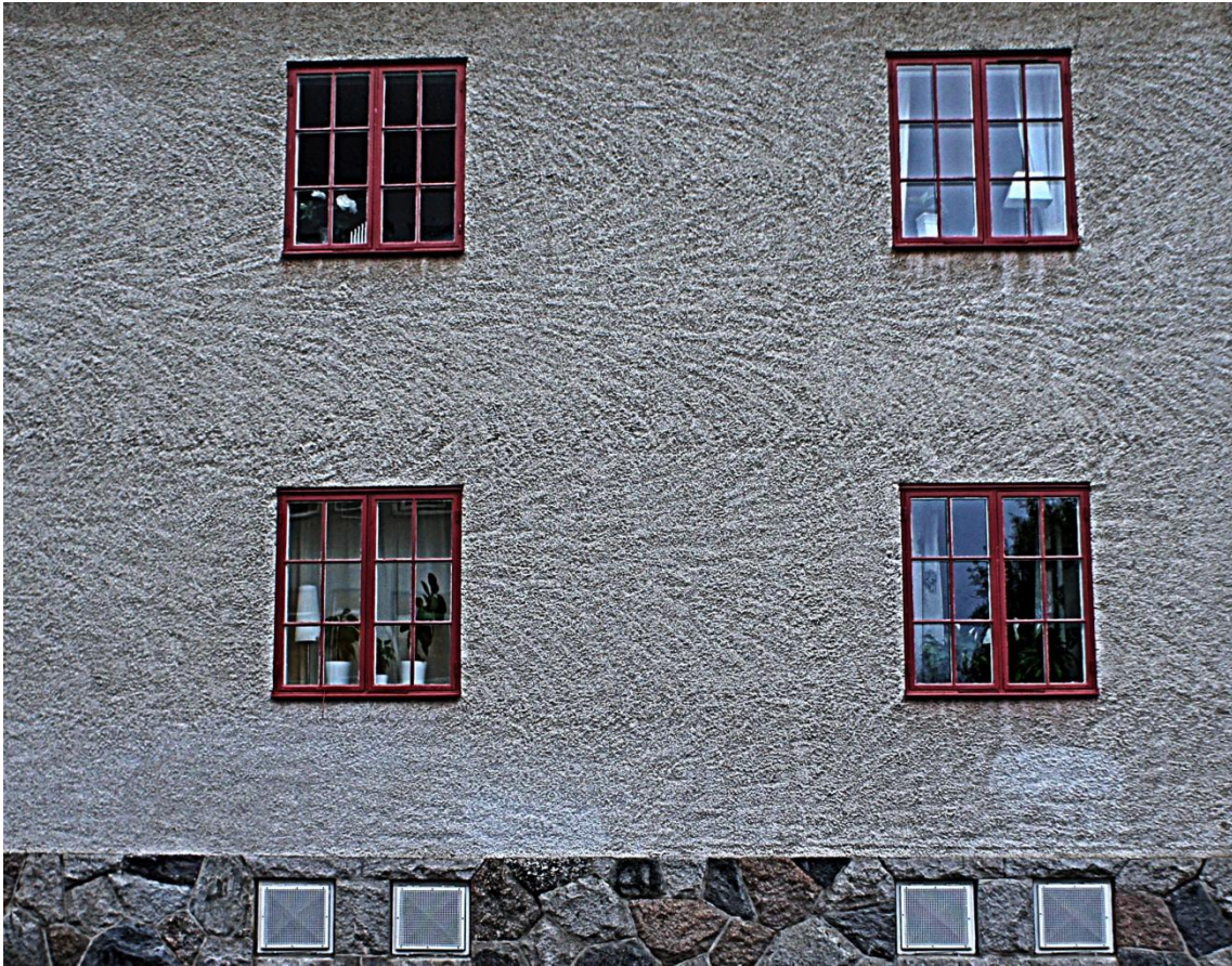
Fig. 4. I den spritputsade fasaden syns spår efter påslagen. Personligen tyckte jag, i början av utbildningen, att spår efter påslag som bildar mönster i fasader kunde vara någonting estetiskt positivt. I en diskussion med min lärare om dessa bågformer hävdade han att de är ett fel, en uppfattning som jag kommit att hålla med om. (Bildens kontraster har förstärkts i bildredigeringsprogram för att tydliggöra påslagen).
