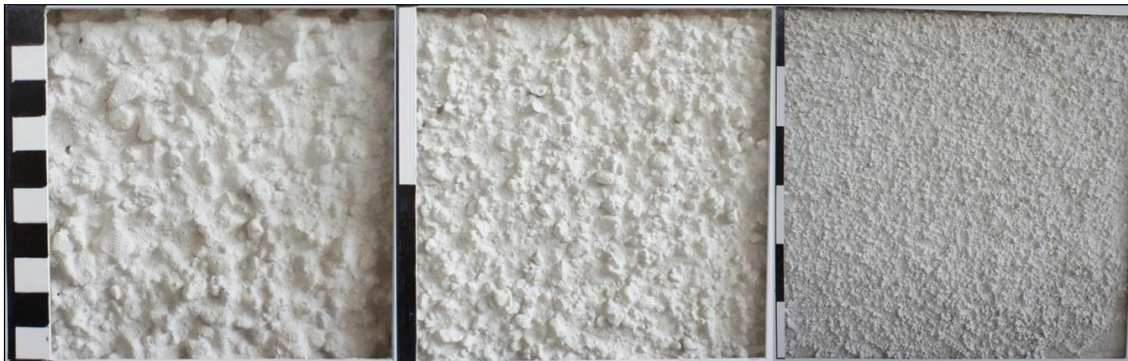
Blandning 41b, mellangrov spritputs, andel finsand 34 %, andel ärtgrus: 66 %.
