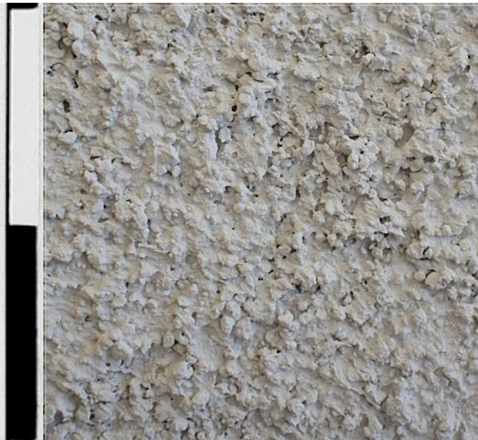
Fig. 4. I den spritputsade fasaden syns spår efter påslagen. Personligen tyckte jag, i början av utbildningen, att spår efter påslag som bildar mönster i fasader kunde vara någonting estetiskt positivt. I en diskussion med min lärare om dessa bågformer hävdade han att de är ett fel, en uppfattning som jag kommit att hålla med om. (Bildens kontraster har förstärkts i bildredigeringsprogram för att tydliggöra påslagen).
