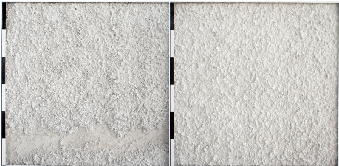
Fig. 18. Blandningarna 43 och 43b. Det tunnflytande bruket ger en tunnare och jämnare puts medan det tjockflytande bruket ger ett putsskikt som är tjockare och något ojämna i och med att varje påslag gett
