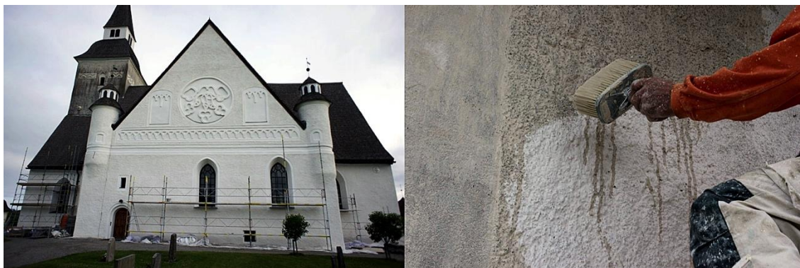
Fig. 2 Till vänster: Sorunda kyrka. Högra bilden: Avfärgning av spritputsen på Ytterjärna kyrka.
