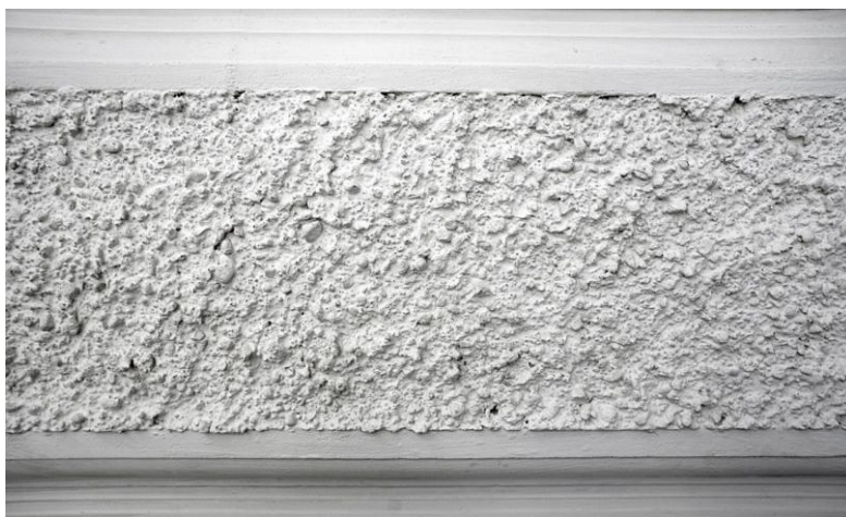
Fig. 1. Ett fasadelement som består av två längsgående lister med ett cirka 35 cm mellanrum som är ifyllt med en grov spritputs.
