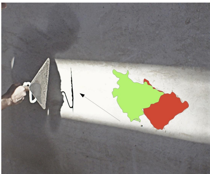
Fig. 12. Det andra påslaget görs bort ifrån det första påslaget.
