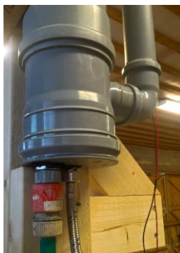
Figur 79 Anslutning av slang för vattenpåfyllning till vänster och slang för anslutning till spridningsrampen till höger.
