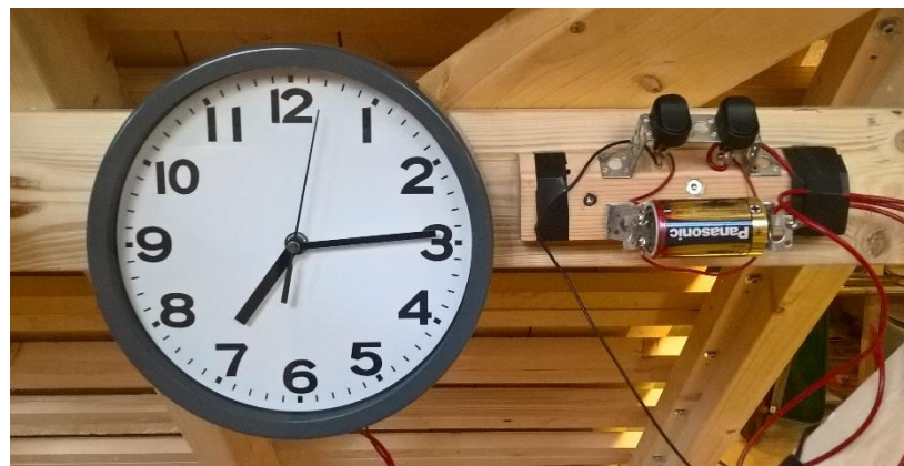
Figur 80 Klocka, batteri och strömbrytare 1 till vänster och strömbrytare 2 till höger monterades på baksidan av stommen. Strömbrytarna står i läge till i figur. Runt hörnet under vattenbehållaren i figur 68 sitter klockan.
