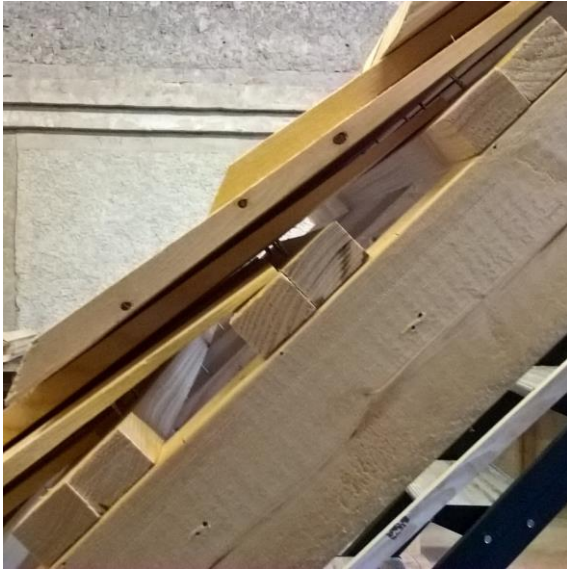
Figur 63 Raka spån med fas sett från sidan. Den nedre läkten av de i par är en permanent del av stommen och används bara som stöd. I den övre läkten skruvas spånen fast strax ovanför underliggande spåns toppända.
