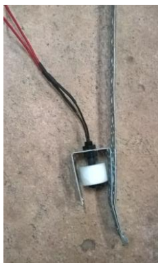
Figur 72 Nivåströmbrytare monterad på hålbänd.
