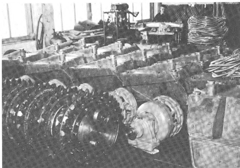
Stridsvagnstillverkningen var baserad på ett nät av underleverantörer. Bilden visar delar i väntan på montering vid Landsverk. Man urskiljer drivhjul, växellådor, bensintankar och elledningar. Juni 1941 (Fst pressdetalj).
