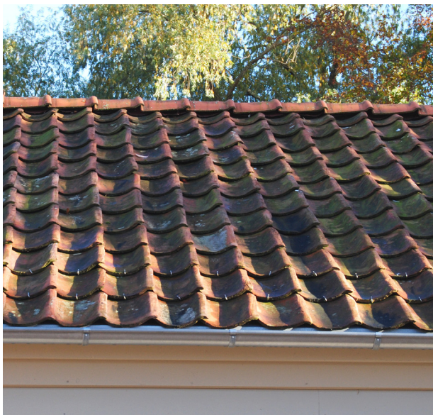
Figur 3.1. Handslaget taktegel som bränts i vedeldad ugn ger en varierad och "levande" takyta.
