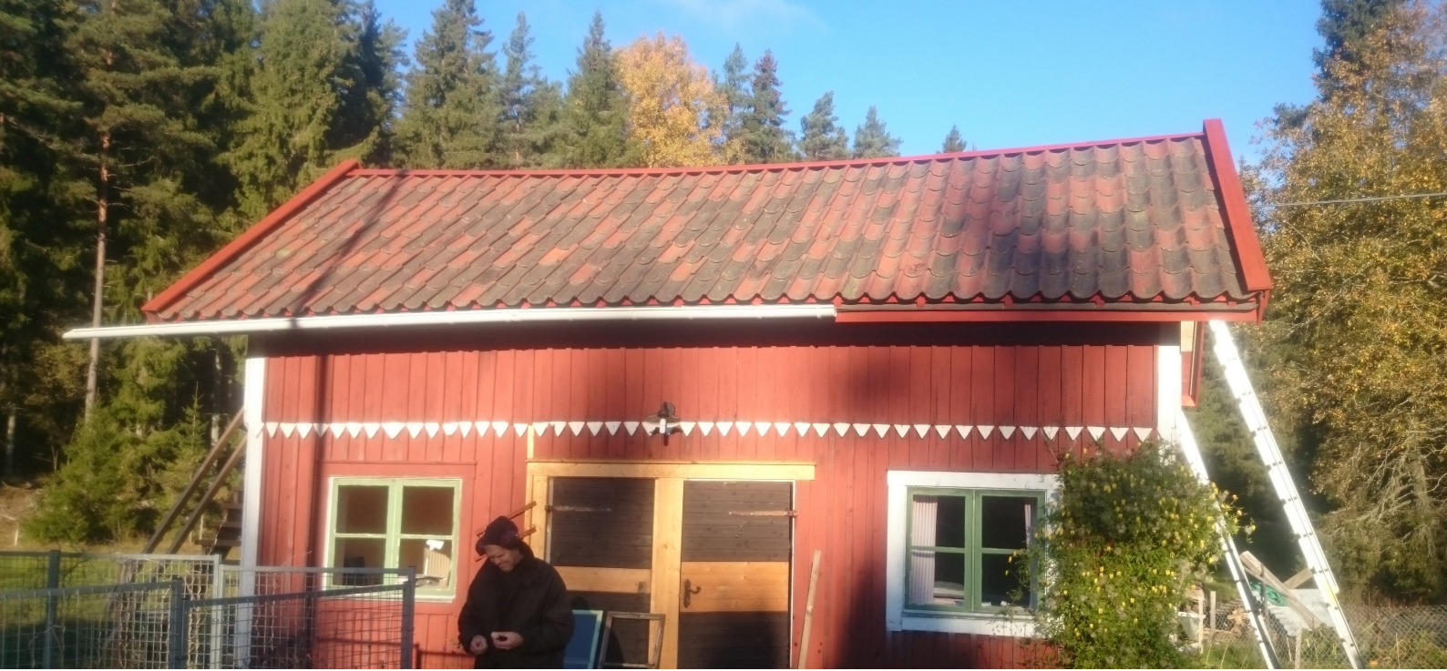
Figur 5.2. Här har det gamla teglet kompletterats med nytt av samma modell som tidigare, det är viktigt att de nya pannorna blandas in med de befintliga för att taket skall bli snyggt. Foto: Jon Åhlund.
