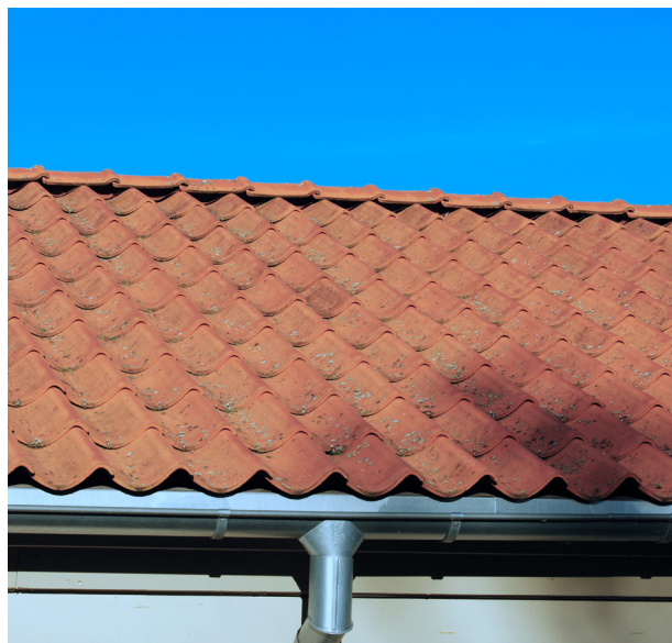
Figur 3.2. Enkupigt taktegel som är strängpressat och bränt i en modern eleldad ugn. Det ger ett i kulör mer jämnt tegel och därmed en mer entonig takyta.
