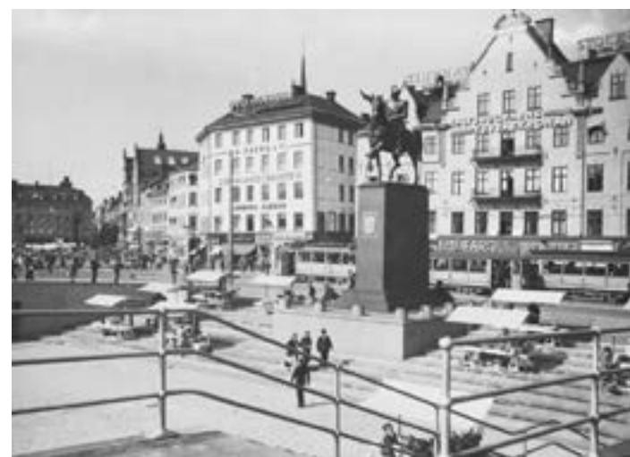
Breda trappor i mötet mellan plattform/torg och Gamla stan, som tar hand om höjdskillnad och som kan fungera som vistelseyta, eller som här; torghandel. Karl Johansslussen, 1936
