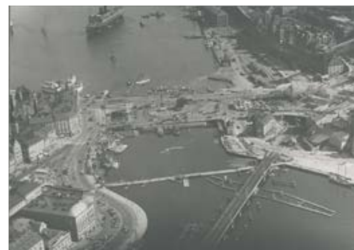
En plattform / ett torg som spänner över hela vattenytan. Nils Ericsons sluss, 1931.
