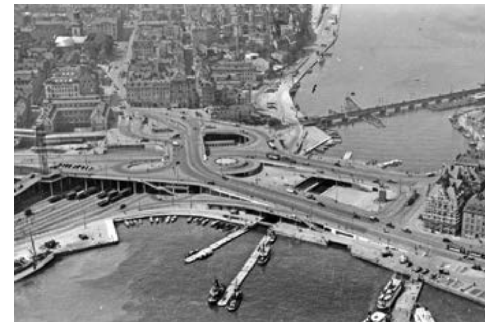
En trafikbro som spänner över hela vattnet mellan Gamla stan och Södermalmssidan. Karl Johansslussen, 1935.
