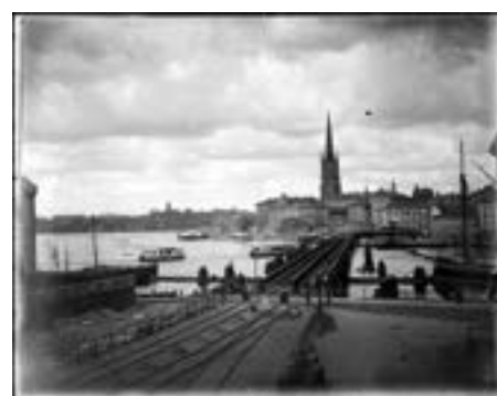
Gångbro i sträckning med bro för spårtrafik. Då sammanbindningsbanan byggdes under 1800-talets andra hälft lades bro för gångtrafik utmed järnvägsbroarnas östra sidor. Södra järnvägsbron, 1896
