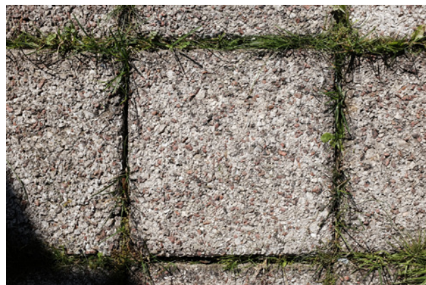
Figur 52. Betongplatta med infärgad yta av krossad sten, 35 x 35 cm.
