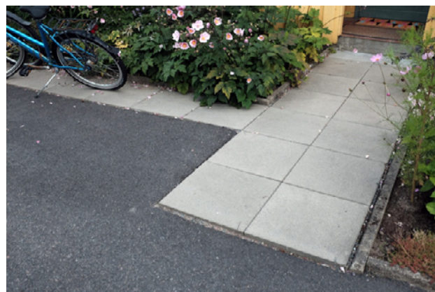
Figur 137. Betongplattor på framsidan 45 x 45 cm.
