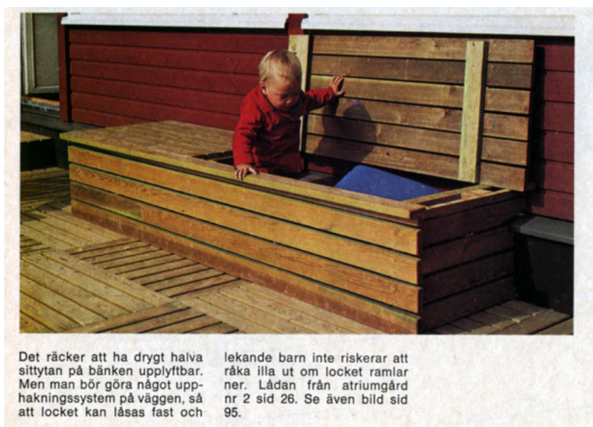
Figur 177. En kombinerad bänk och förvaring byggd av tryckimpregnerat virke. Faksimil ur Trädgården 1974
