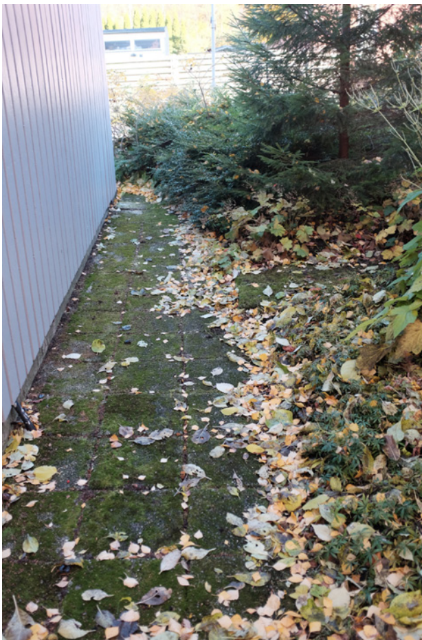
Figur 68. Gång av betongplattor med stenkross söder om garaget.
