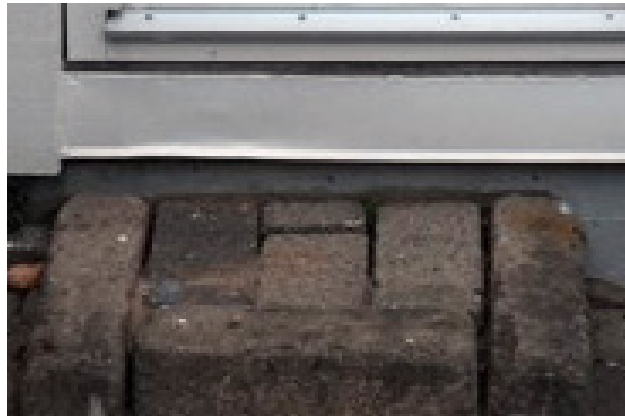
Figur 27. Betongsten som trappsteg och rabattkant.
