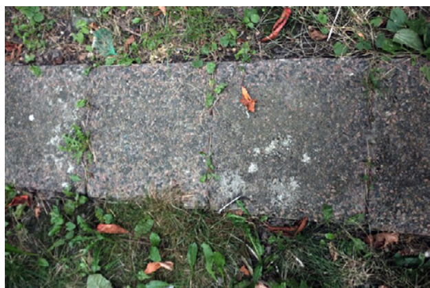
Figur 29. Gång av betongplattor med stenkross.
