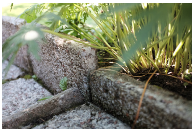
Figur 53. Betongplatta som kantsten.
