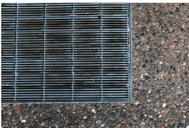
Figur 114. Trappsteg i betong med dansk sjösten och fotskrapa.
