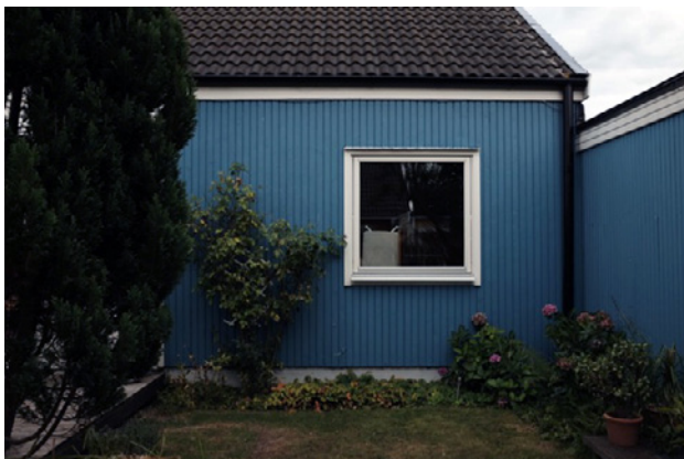
Figur 19. Hörnet mellan uteplatsen och det ombyggda förrådet.
