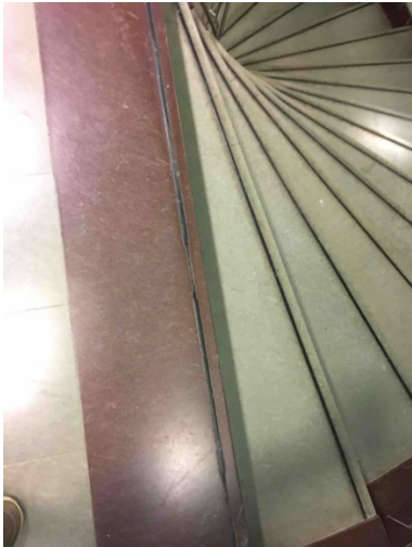
Bild 23. En stentrappa i spiralform som kan öka otryggheten. Gummilister vid trappsteg är på sina ställen utslitna.
