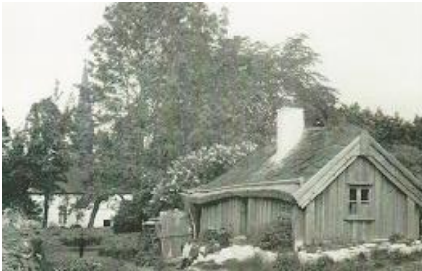
Figur 10. Längs både gavel och långsida på stugan syns det som skulle kunna vara en vitkalkad mullbänk, även skorstenen på taket upplevs väldigt vit. I bakgrunden, bakom de stora träden syns en del av kyrkan (Anderson 1981, s.177).
