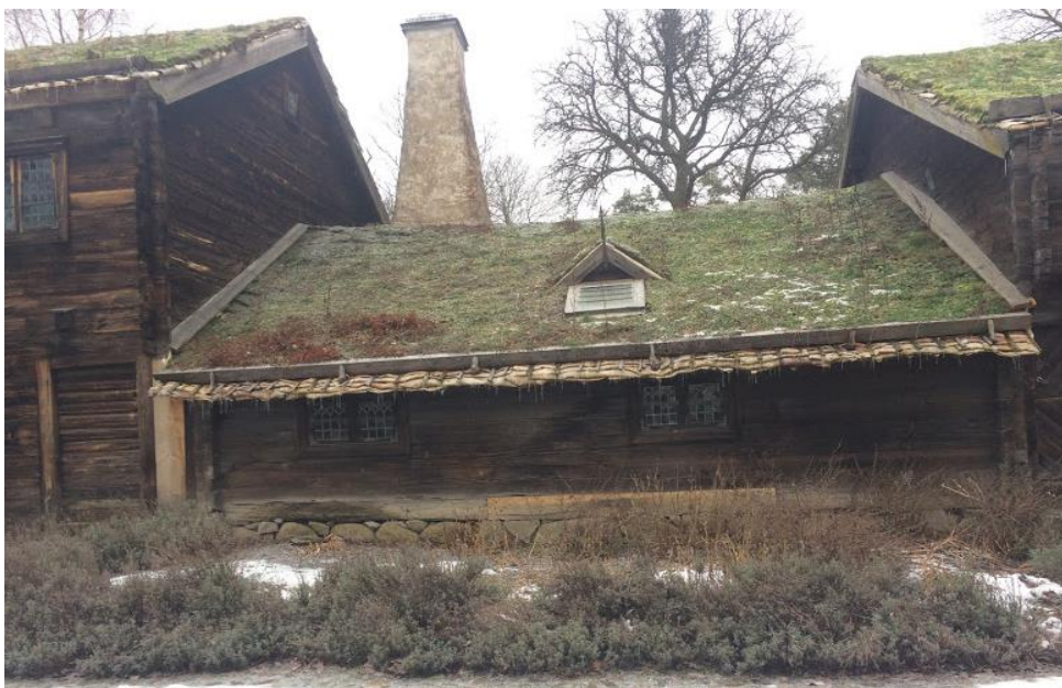
Figur 22. Kyrkhultsstugan 2018. Idag är mullbänken vid Kyrkhultsstugan borttagen och på bilden syns tydligt hur högt upp på stockarna mullbänken sträckte sig (Skog 2018).
