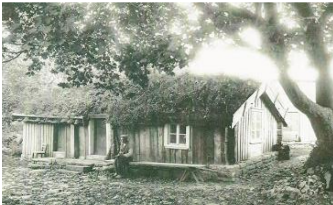
Figur 11. På fotot av ”Friskoppa” stuga från omkring 1900 syns den stenbyggda mullbänken längs med gaveln och långsidan, studeras fotot noga syns det också att stenar ligger likt ett ”lock” över mullbänken på gaveln. Detta ”lock” ser ut att upphöra vid den högra änden av bänken (Andersson 1981, s.155).
