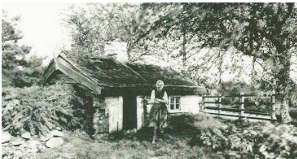
Figur 6. Till höger om kvinnan syns tydligt en skottad mullbänk som är högre in mot stugan och sluttar bort från huset ned till marknivå. Kanske var det såhär mullbänken på Kållandsö såg ut. (Andersson 1981, s. 109).
