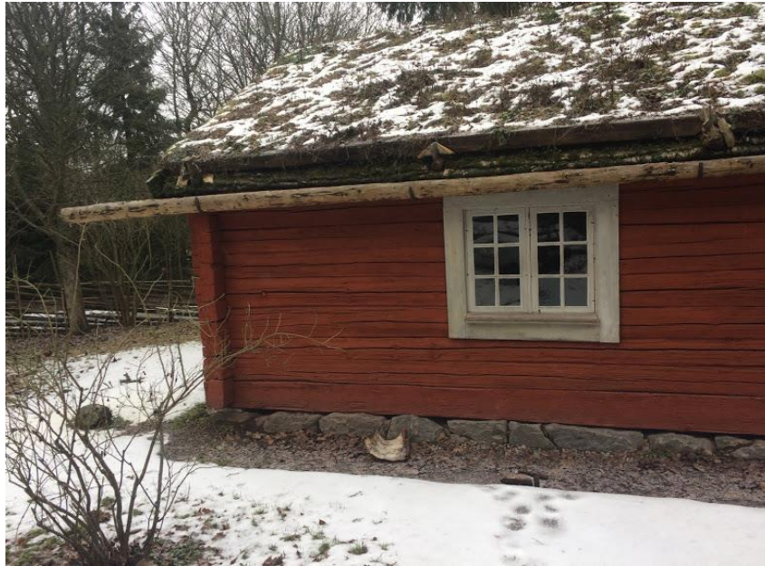
Figur 14. Soldattorpet på Skansen med hängränna (Skog 2018).
