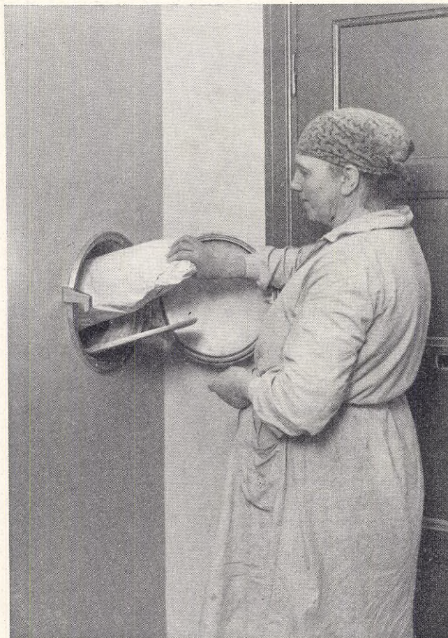
Sopnedkast i H. S. B:s nybyggnader.
