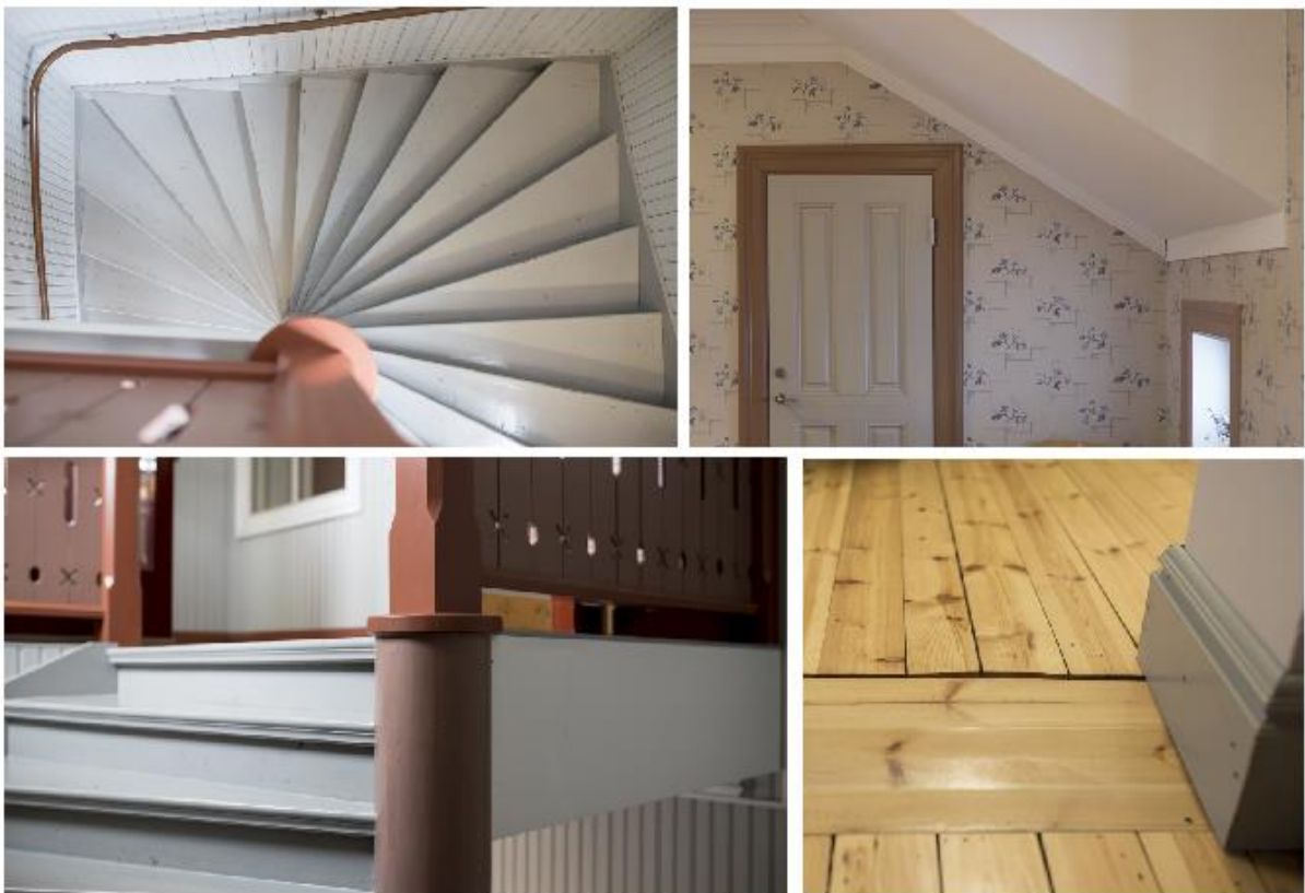
Fig. 13. Bilder som visar på ett urval av färgnyanser och tapetmönster, trappuppgång med pärllspont och träräcke, och grangolv på nedre plan med väggens tjocklek synlig.
