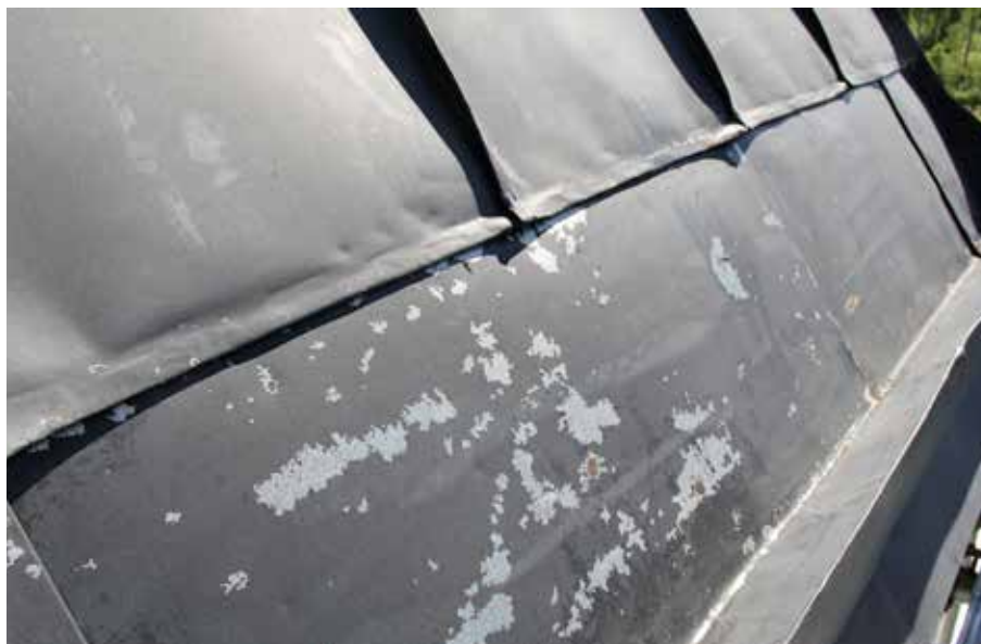
Figur 3.39. Nyare fotplåt med dåligt vidhäftande färgskikt, ruggas upp och betas före målning. Askeryds kyrka, 2017.
