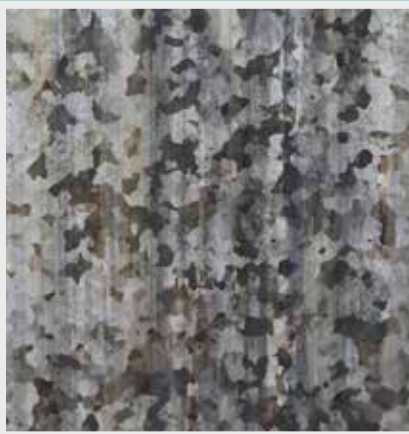
Omålade varmvälsta styckvis varmförzinkade korrugerade plåtar från början av 1900-talet.
