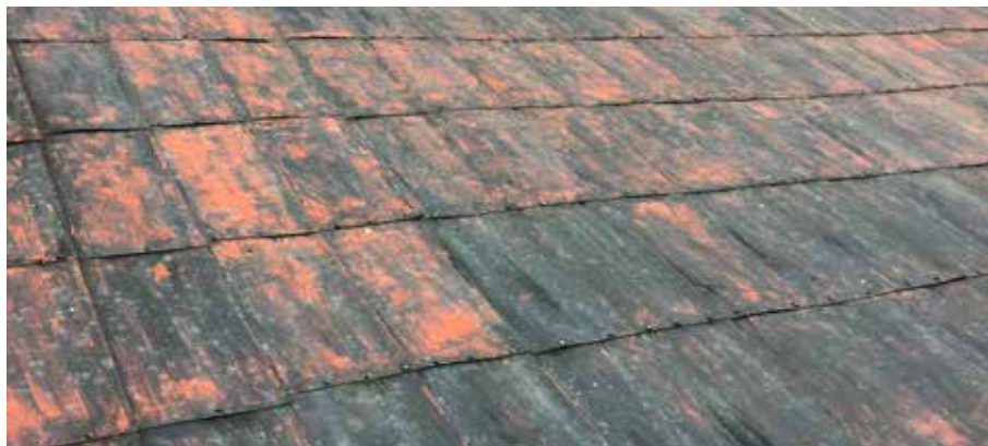
Figur 6.13. Smidd svartplåt på ett av masugnens takfall vid världsarvet Engelsbergs bruk i Västmanlands län. Foto: Christina Persson.
