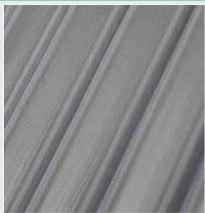
Korrugerade plåtar ommalade med zinkgrå linstandolja.
