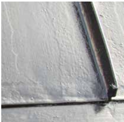
Figur 4.17. Penselstruken yta med alkylid på fabriksbeläggning som delvis avlägsnats. Flisby kyrka, i Nässjö kommun.
