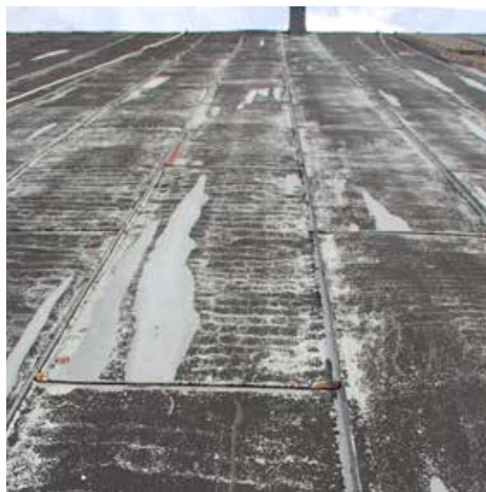
Figur 3.44. Effektiv borttagning av fabriksbeläggning genom högtryckstvätt – 280 bar med roterande munstycke. Flisby kyrka i Nässjö kommun, Småland, 2016.
