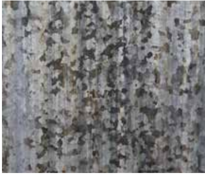
Figur 3.5. Exempel på korrugerad plåt. I det här fallet varmvalsad styckvist varmförzinkad korrugerad plåt från början av 1900-talet.
