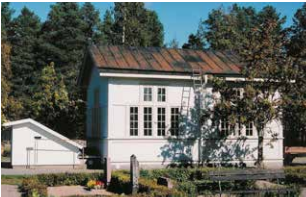
Gravkapellet i Fällfors före åtgärder 2005. Foto: Annika Lindberg.
