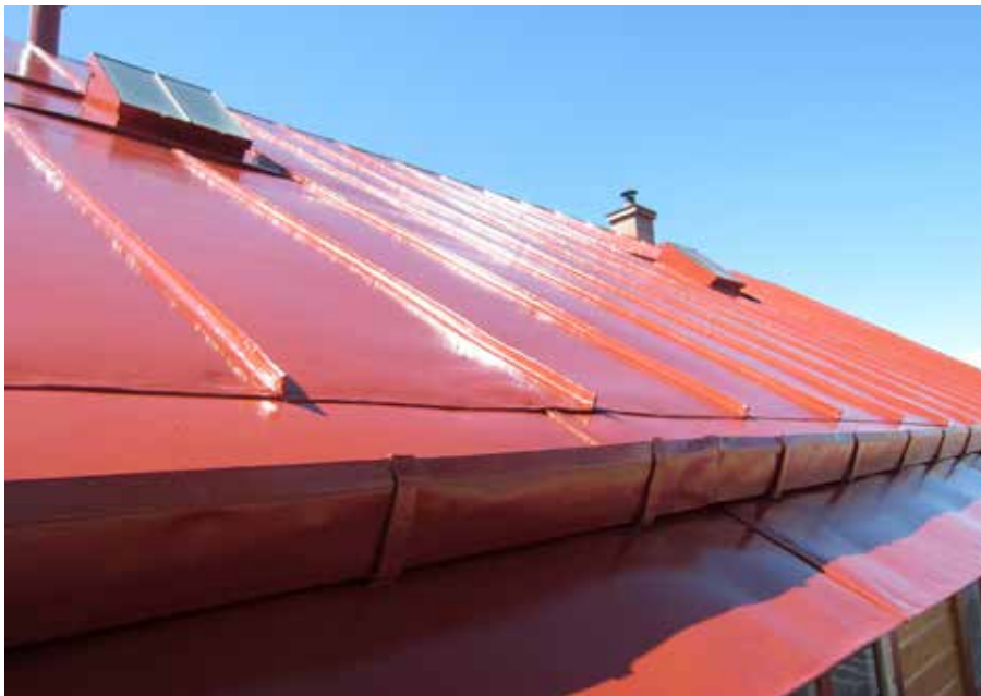
Figur 6.23. Den gamla möbelfabrikens tak efter målningsunderhåll.
