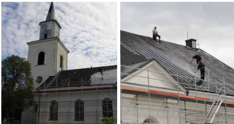
Figur 6.11. och 6.12. Flisby kyrka med ett fabriksbelagt plåttak från 1985. Takfallet tvättas och grundmålas.
