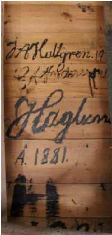
Figur 4.9. Plåtslagare och målare har sedan 1881 lämnat anteckningar om utförda arbeten. Flisby kyrkas torn, Nässjö kommun, 2016.
