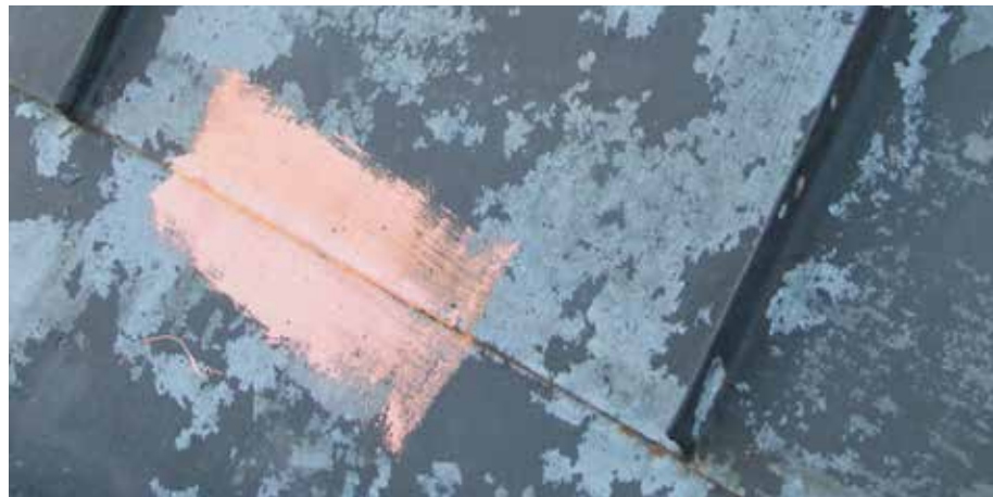
Figur 6.14. Blymönja som varit exponerad i cirka en månad, visar tydlig blekning. Den förspåras också av solljuset och bör övermålas snart efter att den torkat.
