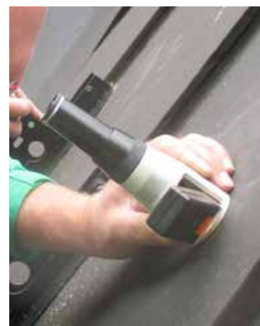
Figur 4.45. Kontroll av färgfilmstjocklek med borrhprov. Både total tjocklek och respektive målnings-skikt kan mätas.
