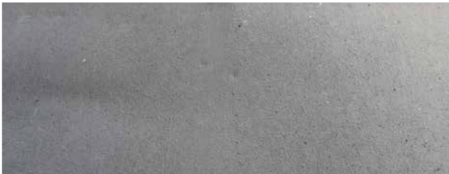
Figur. 3.51. Typiskt utseende, som visar rollerappliceringens prickiga karakteristik.
