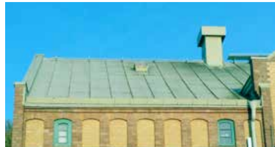
Den kallvalsade och varmförzinkade plåten på Strömstad station före ommålning. Foto: Dan Hansen, 2016.
