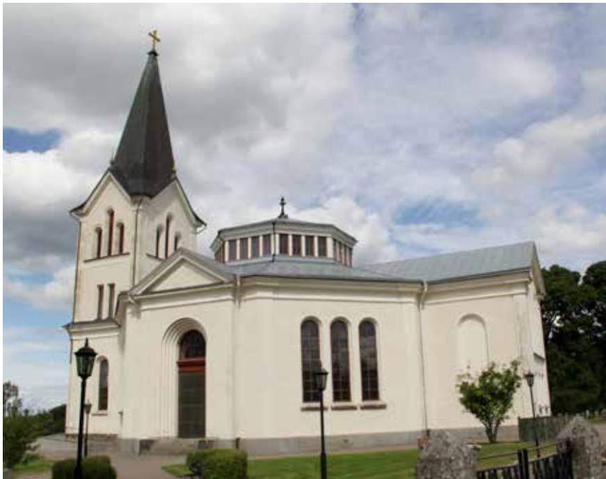
Figur 6.17. och 6.18. Kallvalsat och varmförzinkat plåttak som lämnats att "vädra" på obestämd tid. Öggestorps kyrka i Jönköpings kommun, foto från 2016.
