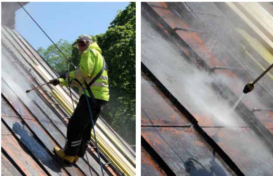
Figur 3.42. och 3.43. Högtryckstvätt 280 bar kombinerat med manuell skrapning och slipning. Habo kyrka i Skara stift, 2015.
