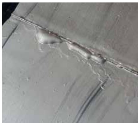
Figur 3.48. Färgskikt som målats sen eftermiddag samt mitt på dagen, fukt i färgskikt samt blåsor. Även denna bild är från Thureholms slott. Foto: Ola Svensson.
