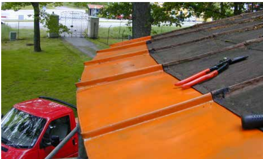
Figur 7.3. Ekotemplet i Stavsjö. Byte av nedersta raden plåt genom att försiktigt bända upp falsarna (Larsson, 2005). Insticksskivor monterades över de gamla svartplåtsskivor som fick vara kvar. Utbytesplåtarna av karosseriplåt oljades in och målades med blymönja i verkstad, av plåtslagarna. Falsarna kittades. Bland annat hittade äldre ytbehandlingsskikt med tjära. Foto: Hugo Larsson, Sörmlands läns museum.
