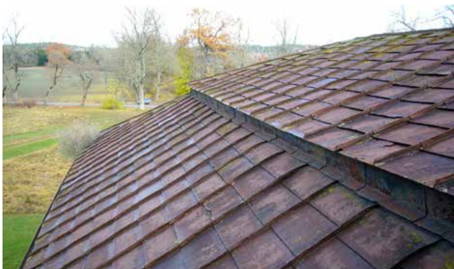
Figur 3.4. Svartplåt med små dimensioner på Tureholms slott i Trosa kommun, Södermanland. Västra stallets plåttak före omläggning, år 2009. Enkelfalsad smidd svartplåt med formatet 45x60 cm och 37 mm falsar. Plåten är antingen från byggtiden, d.v.s. omkring 1730 eller senast från den omfattande reparation som gjordes på 1850-talet. Delar av taket är omhändertaget (Knorring, 2009 och 2011). Foto: Peter von Knorring.
