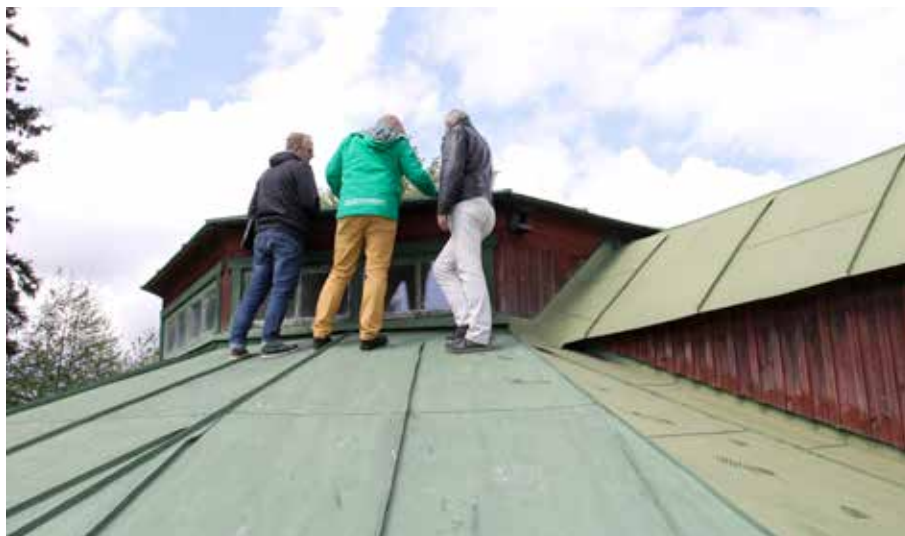
Figur 5.8. År 1993 målades färgprover på taken vid Karlsborgs gamla vattenverk. När Törnblom utvärderade proverna 2009 visade det sig att det gått bra att måla med linoljefärg direkt på förzinkade ytor och på ny galvaniserad plåt. Ytorna hade svepblästrats före målning. Besök i maj 2016.
