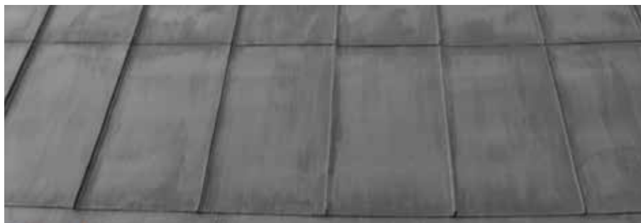
Figur 3.46. Matta ytor p.g.a. nattkondens i nedre takfall. Habo kyrka i Skara stift.
