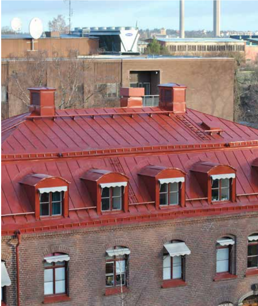
Figur 3.25. Bandtäckning med Prelaq GreenCoat (2007) på en av Sophiahemmet byggnader, Stockholms. Foto: Plåtslageri Jonaeson & Wendel.
