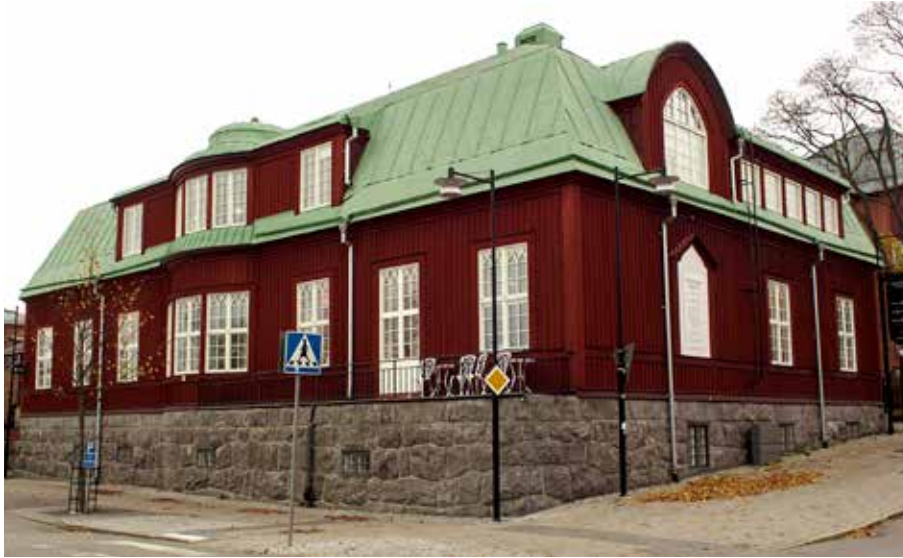
Figur 6.16. Aschanska villan i Umeå (byggt 1906) fick 1996 sitt originalplåttak senast ommålat med en linstandoljefärg med komplexa fosfater i flera lager på penetrerande olja (Grahn, 2017). Plåten är fortfarande i relativt gott skick, men 2017 var taket i behov av tvätt och en förnyad strykning med samma färgtyp. Foto Richard Löwall.
