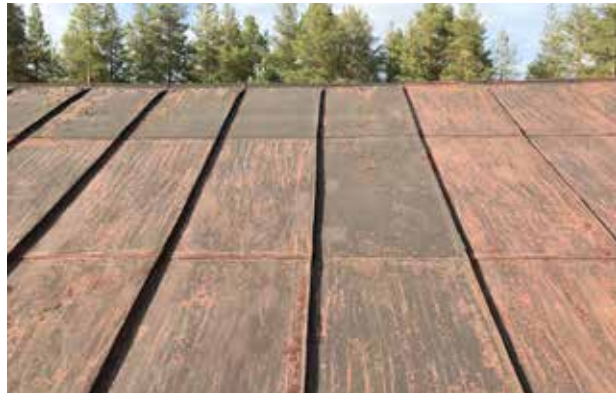
Gravkapellet's tak efter skrapning 2017. Foto: Annika Lindberg.
