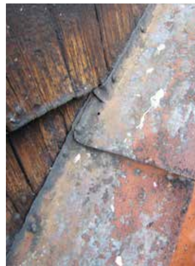
Figur 4.12. Svartplåtsbeslagning kring torn, Göberga herrgård, nära Gripenberg i Tranås kommun. Frontespisernas svartplåtar är numera bytta utan att någon dokumentation gjordes.
