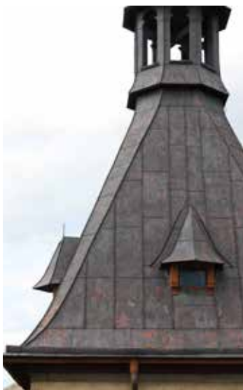
Figur 6.15. Ursprunglig varmvalsad svartplåt från 1897 på Slottsvillan i Huskvarna.
