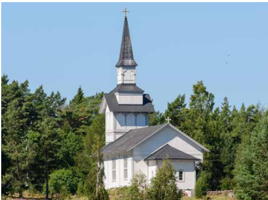
Figur 5.4. Ornö kyrkas korrugerade plåttak byttes 2016, till ett kallvalsat varmförzinkat tak. Fotot visar det gamla taket i augusti 2015. Foto: Arild Vågen, CC BY-SA 4.0, Wikimedia commons.
