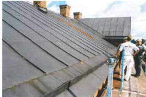
Byggnad B60 vid Vanäsverken i Karlsborg, 2000. Foto: Sven-Olof Hjorth.
