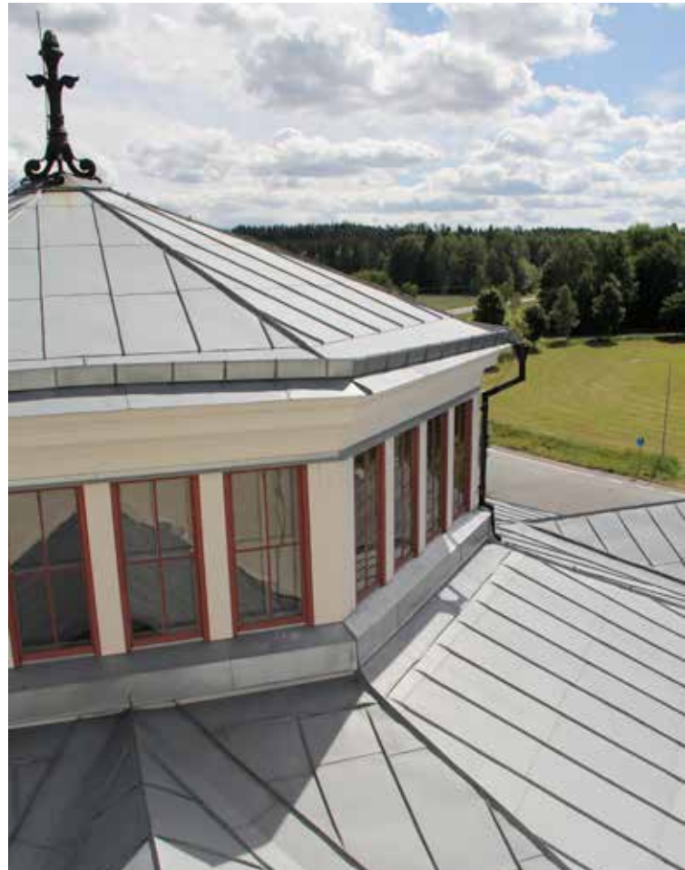
Figur 3.21. Öggestorps kyrka har lämnats omålad för att zinkpatina ska bildas. Det är kallvalsad varmförzinkad plåt. Dagens varmförzinkning är oftast minst 25 µm tjockt och ett tak kan stå omålat relativt länge. Det finns dock risk för att ytrost kan uppkomma i utsatta lägen.
