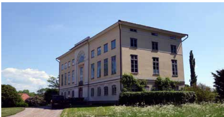
Figur 7.5. Det flacka plåttaket möjliggör underhållsarbete på tak med säkerhetssele. Huvudbyggnaden på Ulvåsa egendom utanför Motala, 2016.
