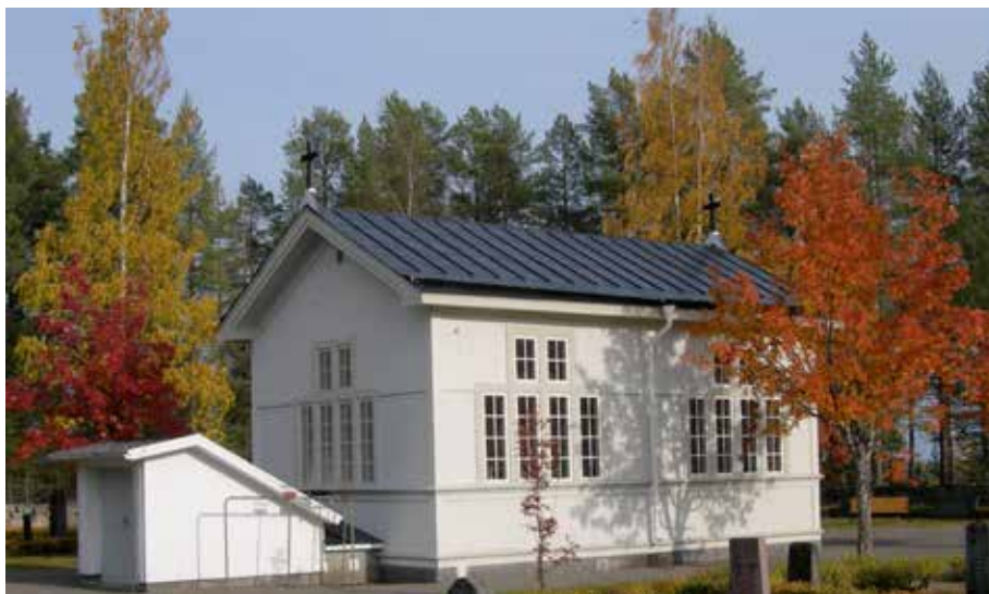
Figur 4.8. Fällfors Gravkapell, i Skellefteå kontrakt, målades om 2006 med linstandoljefärg på rostskyddsfärg (fosfat i alkydolja, Lindberg, 2006).
