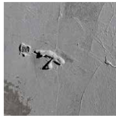
Figur 4.18. och 4.19. Typiska rollade ytor, polymer. Till höger en närbild på ovanligt ful applicering med kanter efter roller och sliror. Askerö kyrka i Aneby kommun, Linköpings stift.
