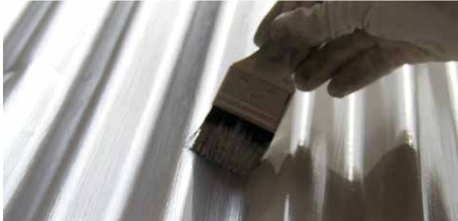
Figur 3.37. Målning av äldre korrugerad plåt med aluminiumglans (lamellära aluminiumpigment i kvarttungstandolja)
