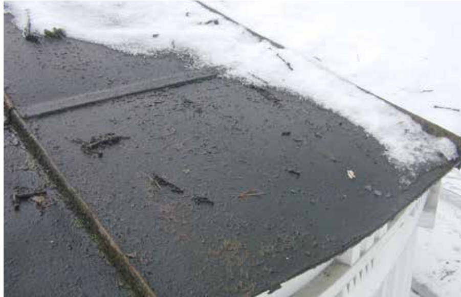
Figur 4.11. Plåttaket på Ekotemplet i Stavsjö visade sig ha en tjärstrykning, som sannolikt var från 1800-talet. Enkelfalsad svartplåt. Foto: Sörmlands museum.
