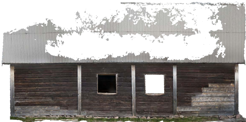
Ovan visas det rektifierade fotot (kraftigt förminskat), svårigheterna att återskapa plåttaket är tydliga.
