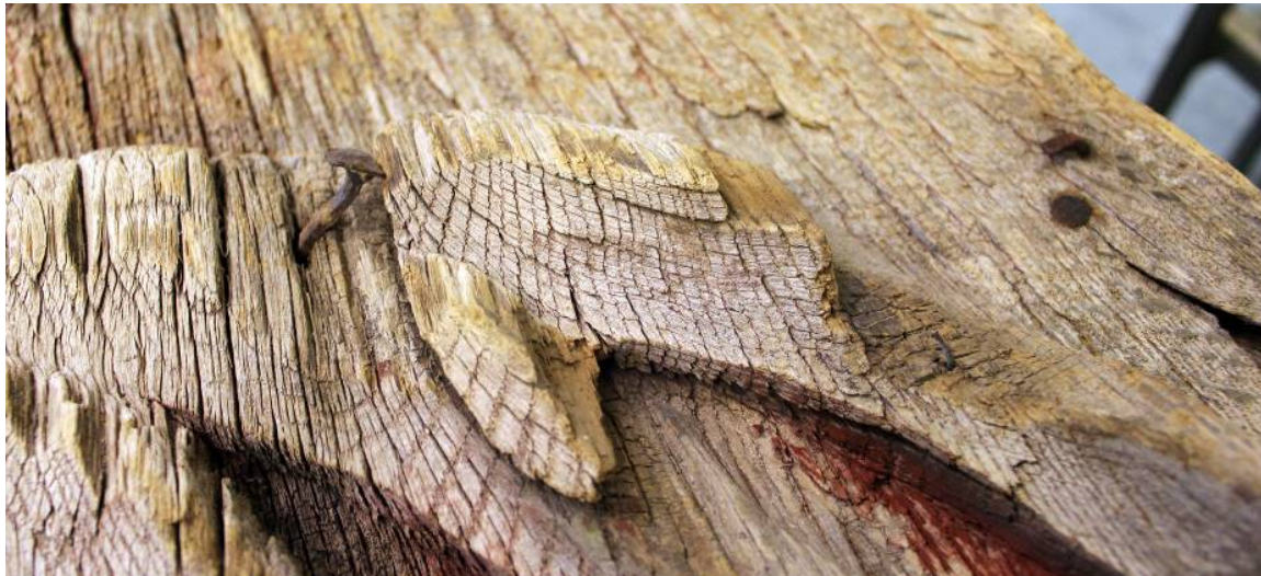
Fig. 26: Bilden visar en handsmidd spik där träbiten som blivit lagad är borta. Även vid den kopparlegerade spiken till höger i bild är träbiten borta, enbart spikarna är kvar. Bild: Angelica Fingal.
