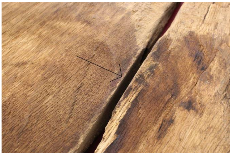
Fig. 21: Bild med pil som visar långsidan som blivit planhyvlad. Bild: Angelica Fingal
