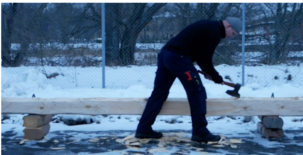
Figur 19. Bilning nivå 2. Foto: Niklas Wahlström
