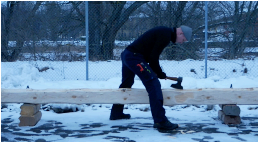
Figur 18. Bilning nivå 2 gränsle. Foto: Niklas Wahlström
