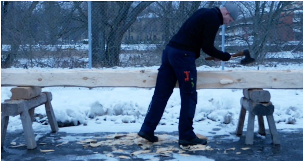
Figur 20. Bilning nivå 4. Foto: Niklas Wahlström
