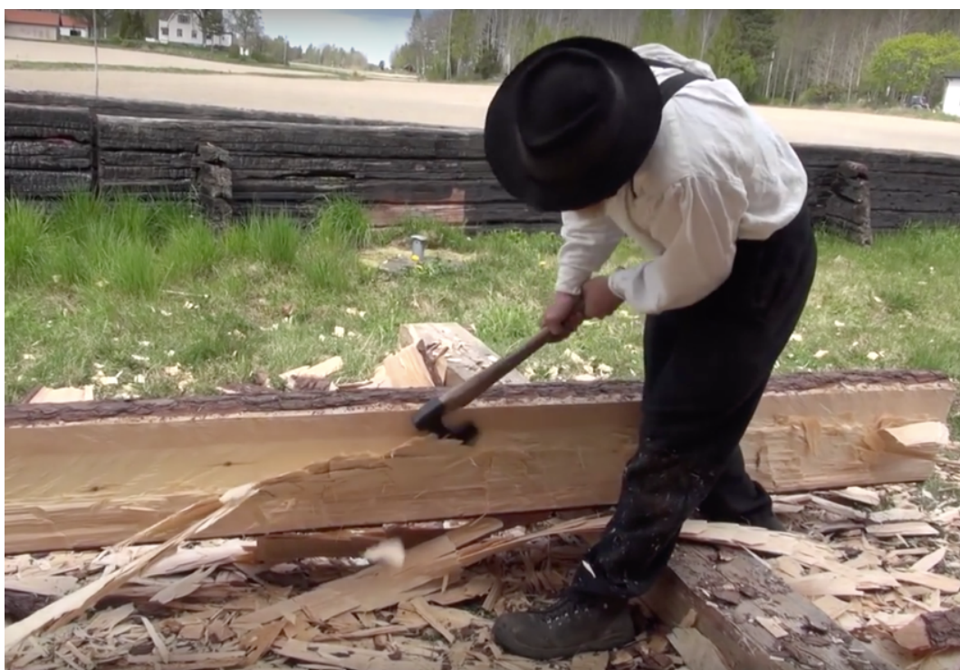
Figur 5. Olof Andersson Sprättäljer en stock till Södra råda gamla kyrka 2015. Foto: Hantverkslaboratoriet
