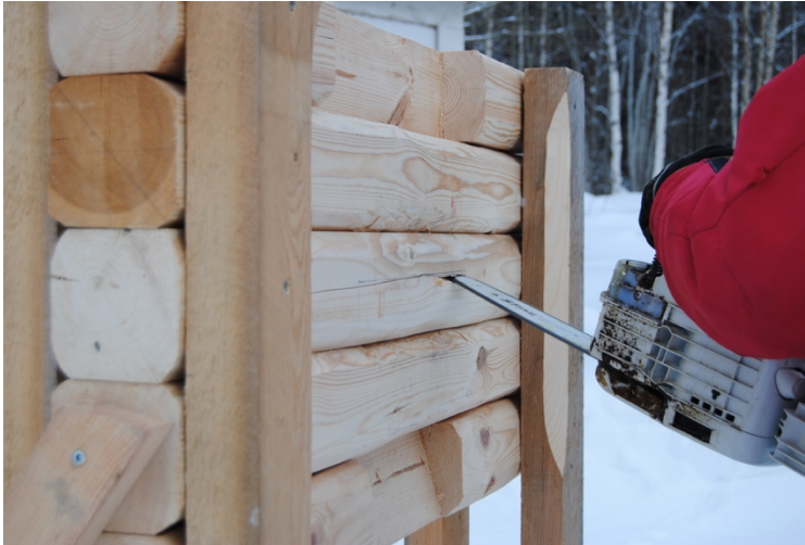
Figur 15: Petter Landin sågar ett vinklat, vågrätt snitt med motorsåg i sin kvartssulning (Toftgård 2018).
