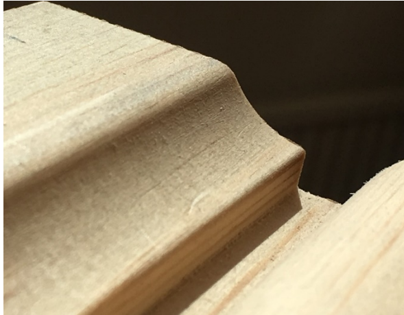
Bild 68. Närbild på maskinhyvlat foder, där kanter som annars är skarpa istället är rundade.
