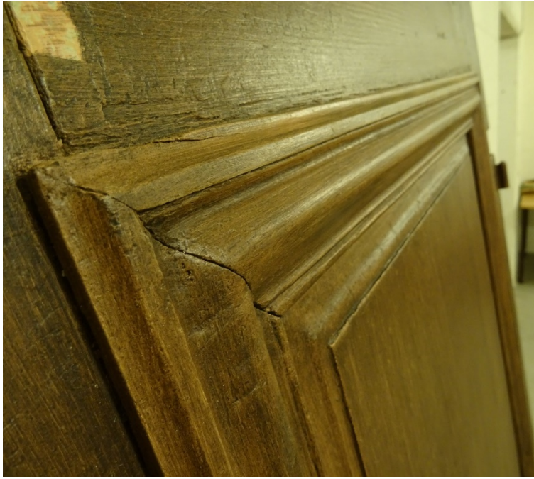
Bild 7. Detaljbild på listen till helfransk ramverksdörr.
