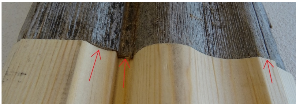
Bild 67. Jämförande mellan originalfoder och maskinhyvlat foder. Röda pilar pekar på de noterbara skillnaderna.
