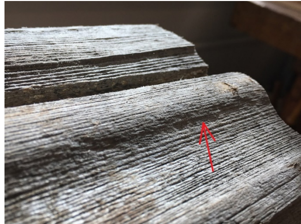
Bild 71. Originalfodret har en liknande skuggning som den handhyvlade kopian, vilket kan tyda på likheter i utförande. Notera de skarpa kanterna på hålkälet i bakgrunden.
