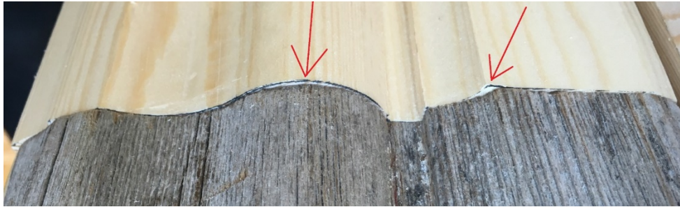
Bild 66. Jämförande mellan originalfoder och handhyvlat foder. Röda pilar pekar på de noterbara skillnaderna.
