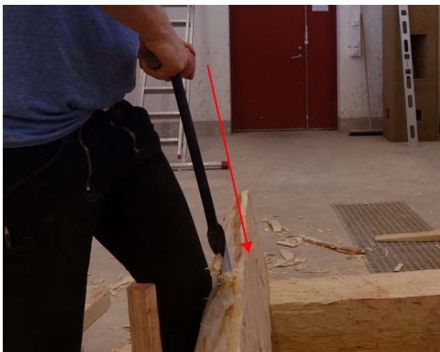
Figur 88 Borrning med konisk spiralnavare görs parallellt med ovansida
