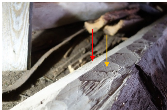
Figur 10 Huggning av smalsida. Gul pil visar steg ett: grövre huggning för avverkning, röd pil visar steg två: huggning efter rak linje. Pilarna visar även yxans riktning
