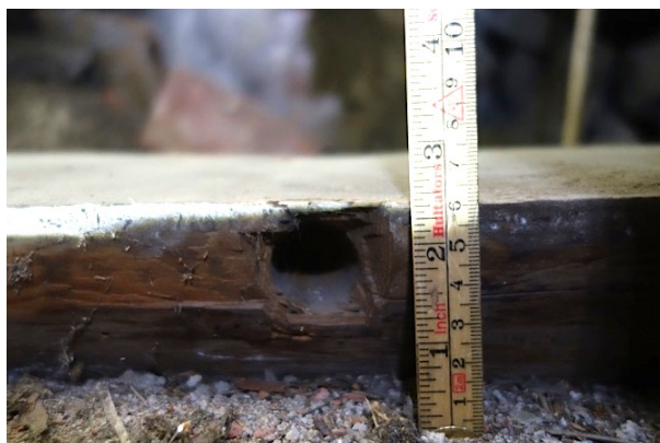
Figur 21 Stämjärnsspår ca 1" vid dubbhål
