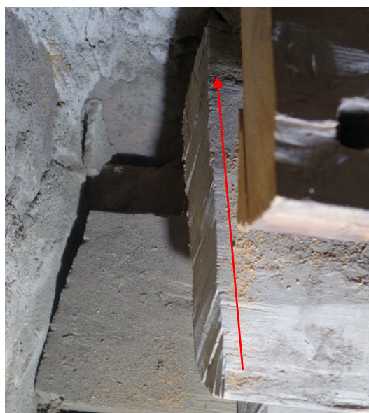
Figur 18 Ändkap gjort med yxa, röd pil visar huggens riktning
