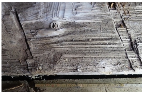
Figur 9: Spår från klamphuggning och skyrhuggning
