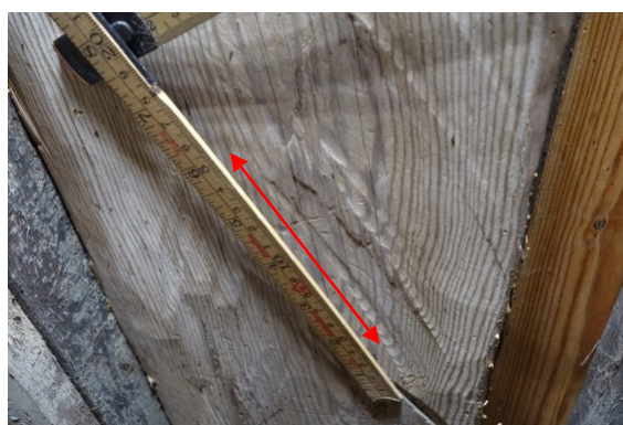
Figur 40 Röd pil visar uppmätning av yxans egglängd ca 14 - 15 cm
