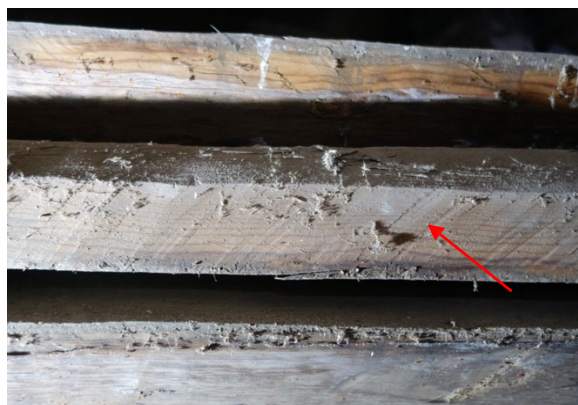
Figur 16 Huggning av smal sida. Röd pil visar yxans huggriktning i ca 45° med ovasidan
