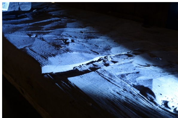
Figur 24 Undersidans skyrhuggning
