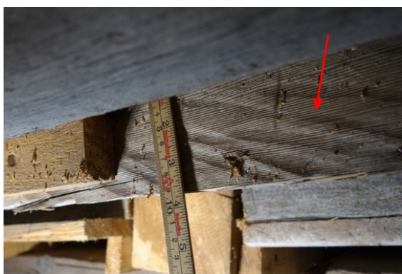
Figur 39 Röd pil visar yxans huggriktning på smalsida, som är huggen ur vinkel.
