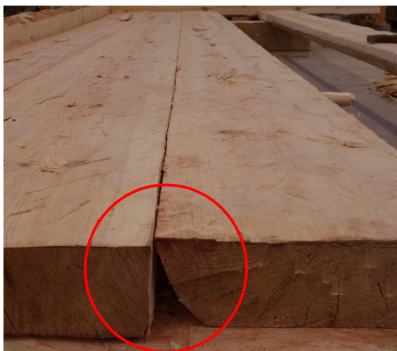
Figur 74 Mötet mellan plankorna. Vankant lämnas helt på den högra
