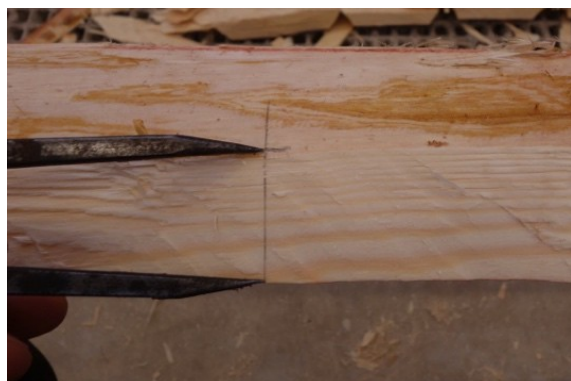
Figur 79 Uppmärkning av dubbhål med passare
