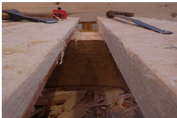
Figur 76 Sågningen sker som komplement på båda plankornas smalsidor
