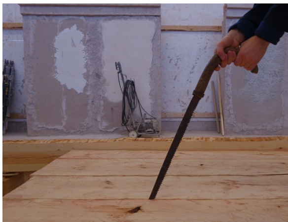
Figur 75 Sågning av golvplank
