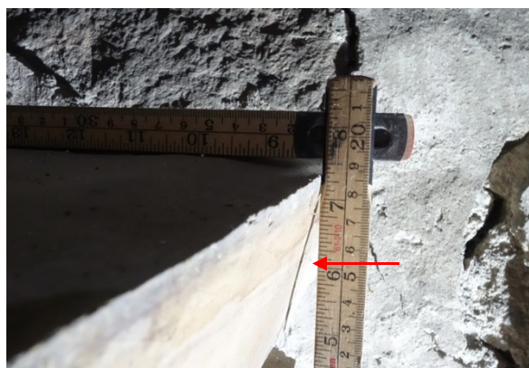
Figur 19 Smalsidan är huggen ur vinkel. Röd pil visar konisk huggning av smalsidan
