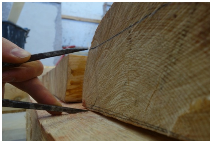
Figur 59 Urtag på halvklova
