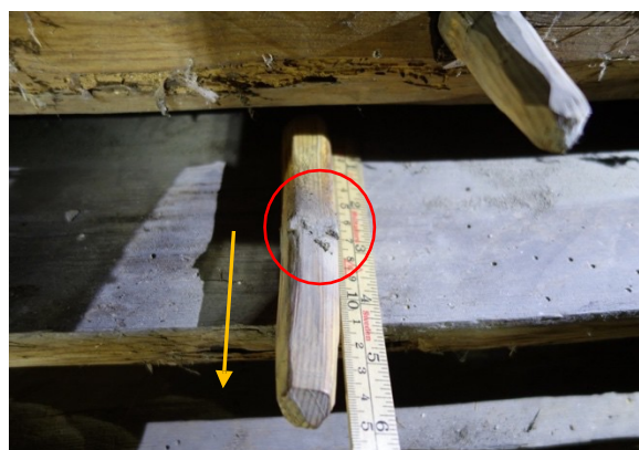
Figur 20 Röd cirkel visar mötet mellan planken samt spår från kniv. Gul pil visar knivens skärriktning. Dubben är av furu och är ca 15 cm.
