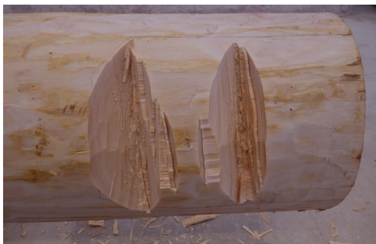
Figur 60 Upplättningshugg på halvklova
