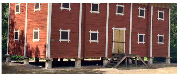
Figur 31. Visar en lagerbyggnad som undersöktes vilken har en öppen grund. Foto: Malena Gyllenbak.
