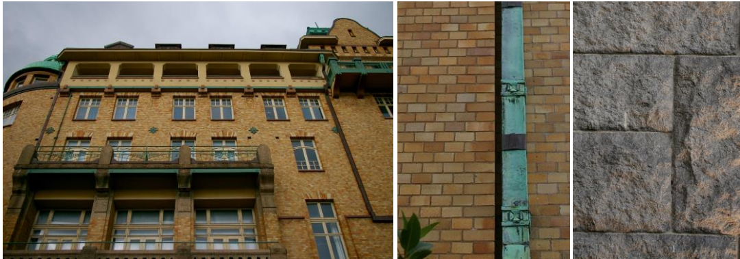
71. Balkong och fönster åt Bastionsplatsen. 72. Materialanvändning: Skrombergategel, koppar och granit.
