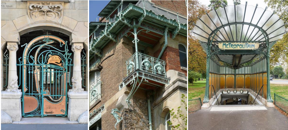
Från vänster till höger. 4. Porten på Castel Béranger i Paris av Hector Guimard. 5. Balkong och takfot på Castel Béranger. 6. Metropolitan Porte Dauphine i Paris av Hector Guimard.
