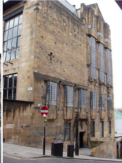
9. GSAs huvudbyggnad och tillbyggnad.
