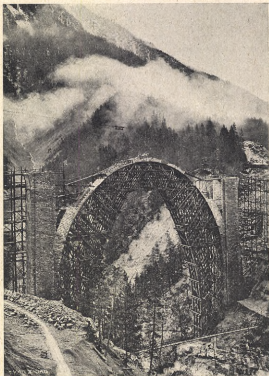
ETT INGENJÖRSKONSTENS MÄSTERVÄRK: JÄTTEVIADUKTEN VID WIESEN I SCHWEIZ. (Efter fotografi.)
