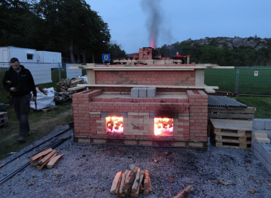
Figur 3. Svenneby Bohuslän, strax söder om kyrkan på ett fält byggdes ugn C. Under eldningen uppträder rörelsesprickor på ugnens ytterväggar. Att sprickor kan uppstå hänger samman med den längdförändring som uppstår i byggnadsmaterialen när temperaturen förändras. Problemet förutsågs och diskuterades där en tanke var att förse ugnen med stålband för att hålla ihop den. Men vi provade utan för att se hur temperaturrörelserna påverkar konstruktionen. Temperaturrörelserna gav sprickbildning i konstruktionen och dessa tätades under hand. För att inte större problem skulle kunna uppstå stabiliserades ugnens sidor med plank vilket fungerade väl. I ett fortsatt utvecklingsarbete av ugnen är erfarenheten av betydelse för hur nästa ugn bör konstrueras. I bild Martin Fernström.
