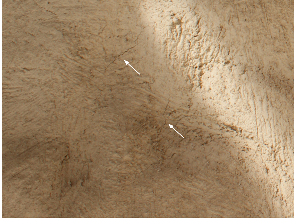
Figur 4. Svenneby gamla kyrka, södra långhusväggen. Figuren visar en närbild av grundningsskiktet (se också fig. 11a). Vid de vita pilarna framträder mycket fina korta krympsprickor. Grundningsskiktet har borstats in i underlaget och över sten och fog. Bruket är mycket bindemedelrikt (1 viktandel kalk på 1 viktandel sand).
