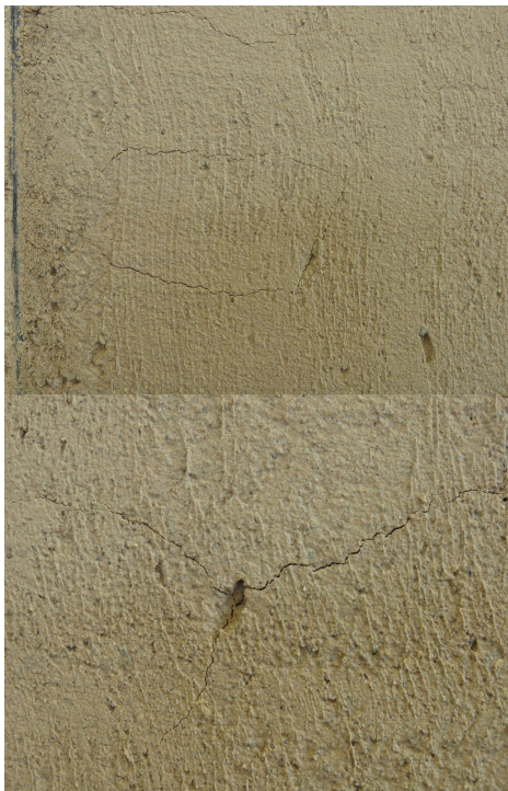
Fig. 1. Göteborgs universitets verksamhets lokaler i Mariestad. Bilden visar utvecklingen av grova krympsprickor i en putsyta 30 min efter att bruket är applicerat på underlaget. När vattnet i bruket avgår till underlaget krymper och deformeras sig bruket plastiskt. Deformationen kan till en vis gräns ske utan att sprickor uppstår. När deformationen blir för stor bildas sprickor som blir bestående. De sprickor som uppstår kan beroende på graden av deformation uppträda som få, små och fina eller flera fina med inslag av grova sprickor. Sprickorna sammanstrålar och bildar ofta en y form. I byggnadslitteratur framgår att krympsprickor är en defekt i bruket (e.g Henström 1869; Dührkop 1966; Hus AMA 83). Foto: Jan Erik Lindqvist.
