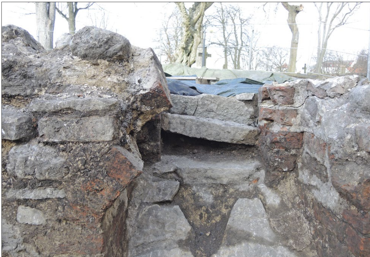
Figur 81. Den ombyggda fönsternischen 644, med den sekundära kalkstenshällen 645.
