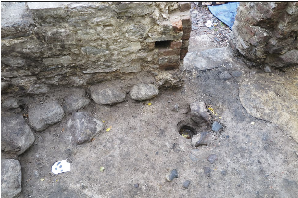
Figur 95. Golvet i den norra källaren är plundrat. I fundamentlagret 710 finns avtrycket efter en stolpe, 711, 713, 718, som troligen stöttat bjälklaget när innerväggens norra sida 697, gjorts om.
