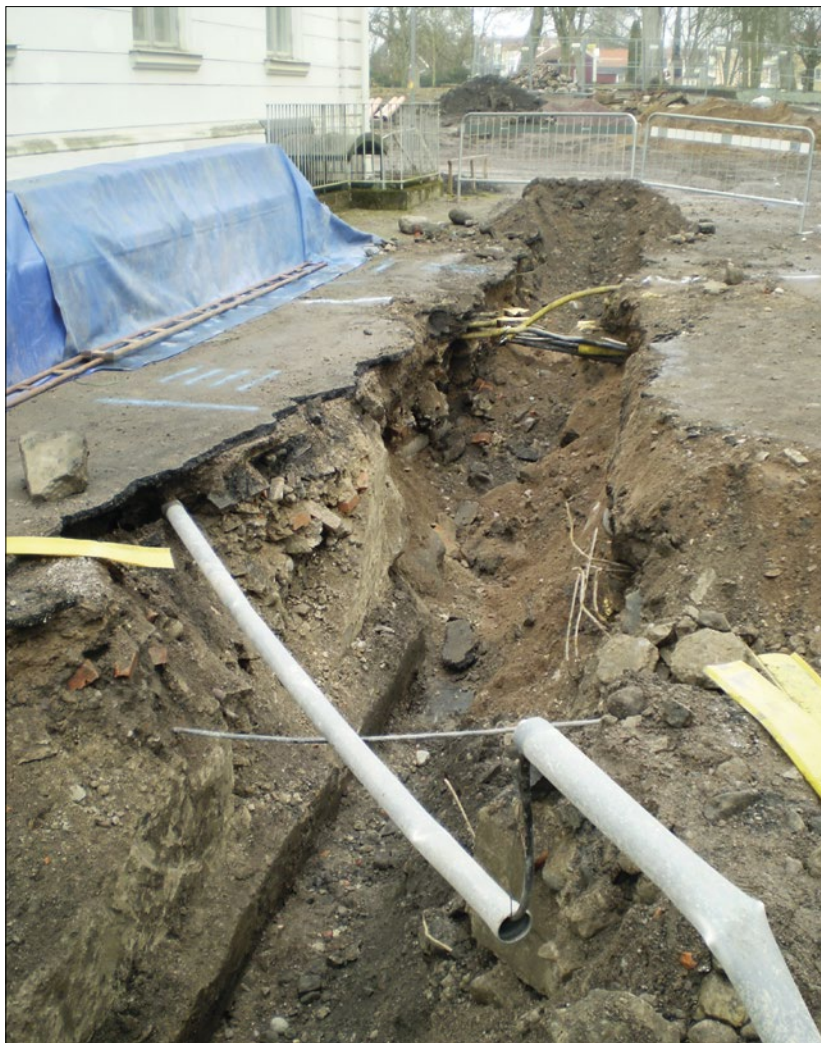
Figur 109. Situationsbild över det nya schaktet och dess sträckning mellan de stående byggnaderna. I förgrunden syns en del av betongmuren 633. Som framgår fanns ett stort antal odokumenterade ledningsdragningar.
