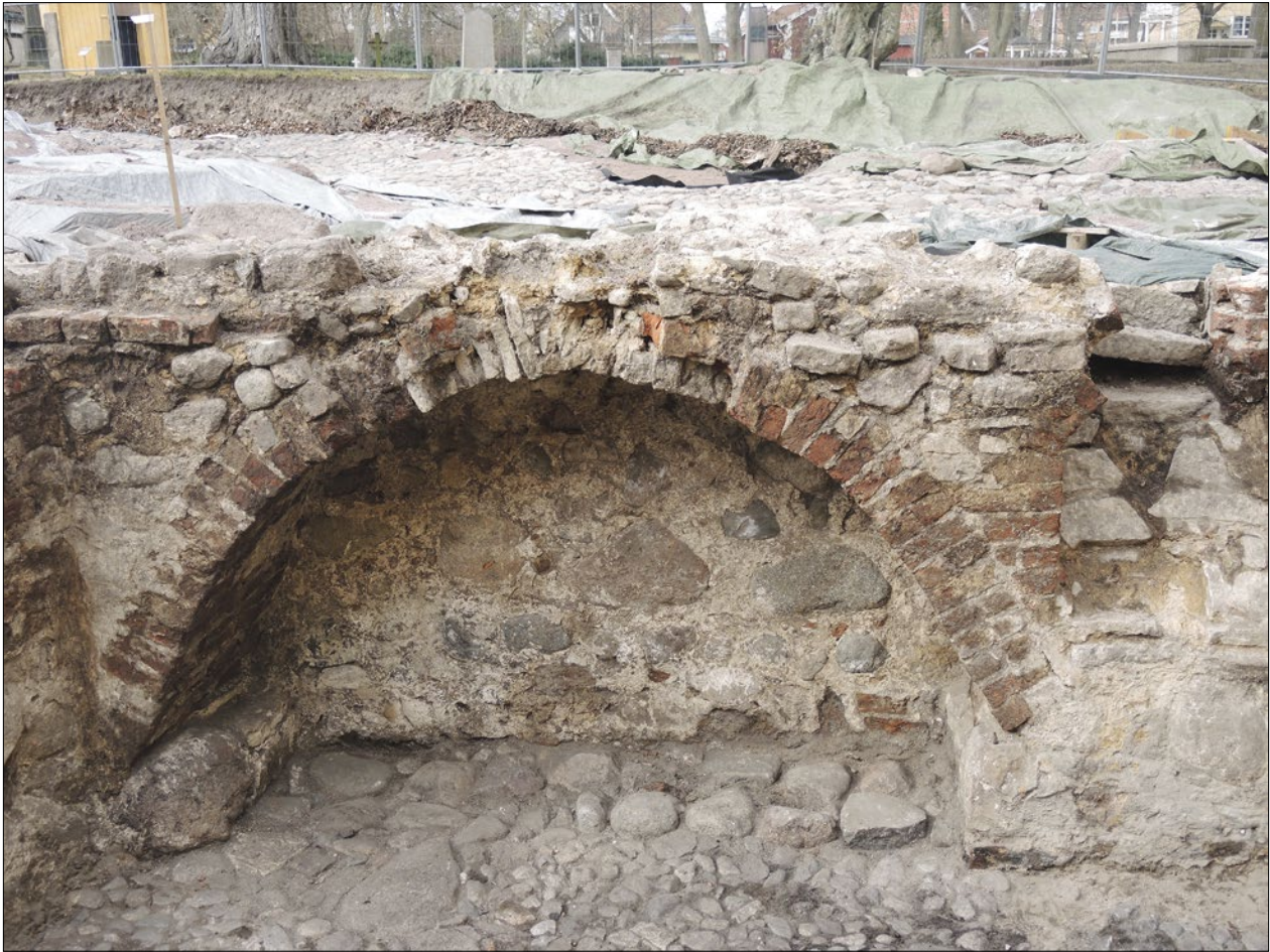
Figur 80. Valvet i den södra källaren i byggnad F. Jämför med Sven Rosmans ritning, fig. 75. I botten syns stenraden 615.
