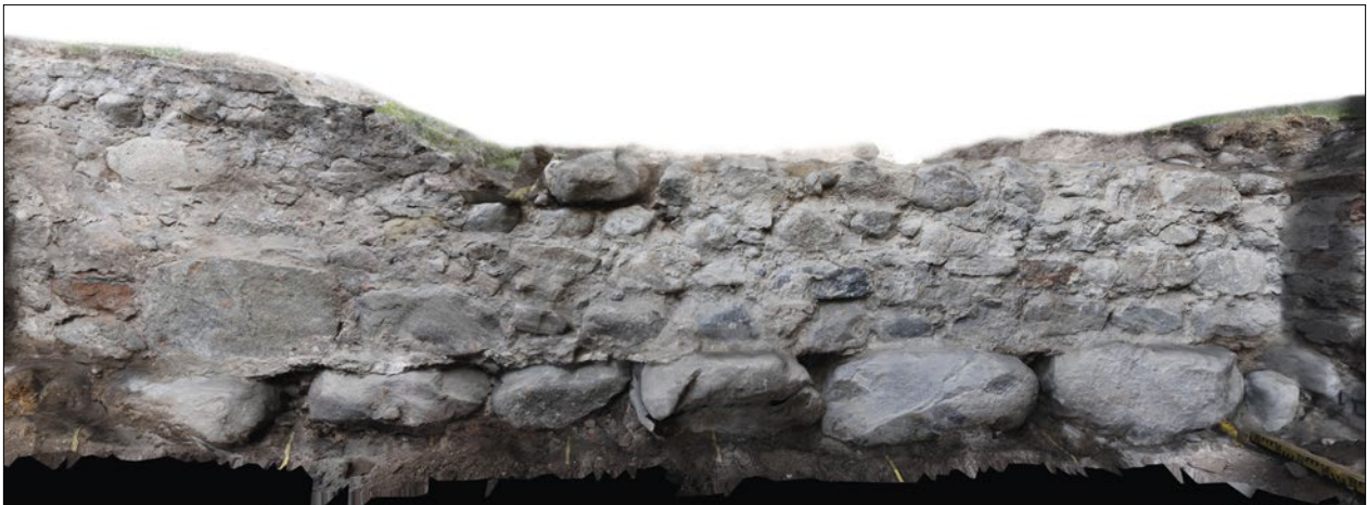
Figur 87. Den västra muren 41=700 i den norra källaren, fotodokumenterad 2011.
