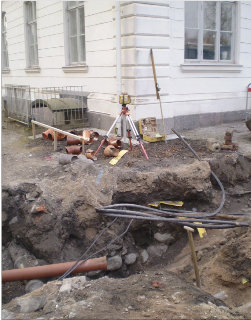
Figur 113. Området vid det nordvästra hörnet av fd Söderportsskolan var kraftigt skadat till följd av en stor mängd tidigare ledningsdragningar. Under dessa framkom dock några större stenar, 640, som kan vara omrörda lämningar efter det medeltida torgets stenläggning.
