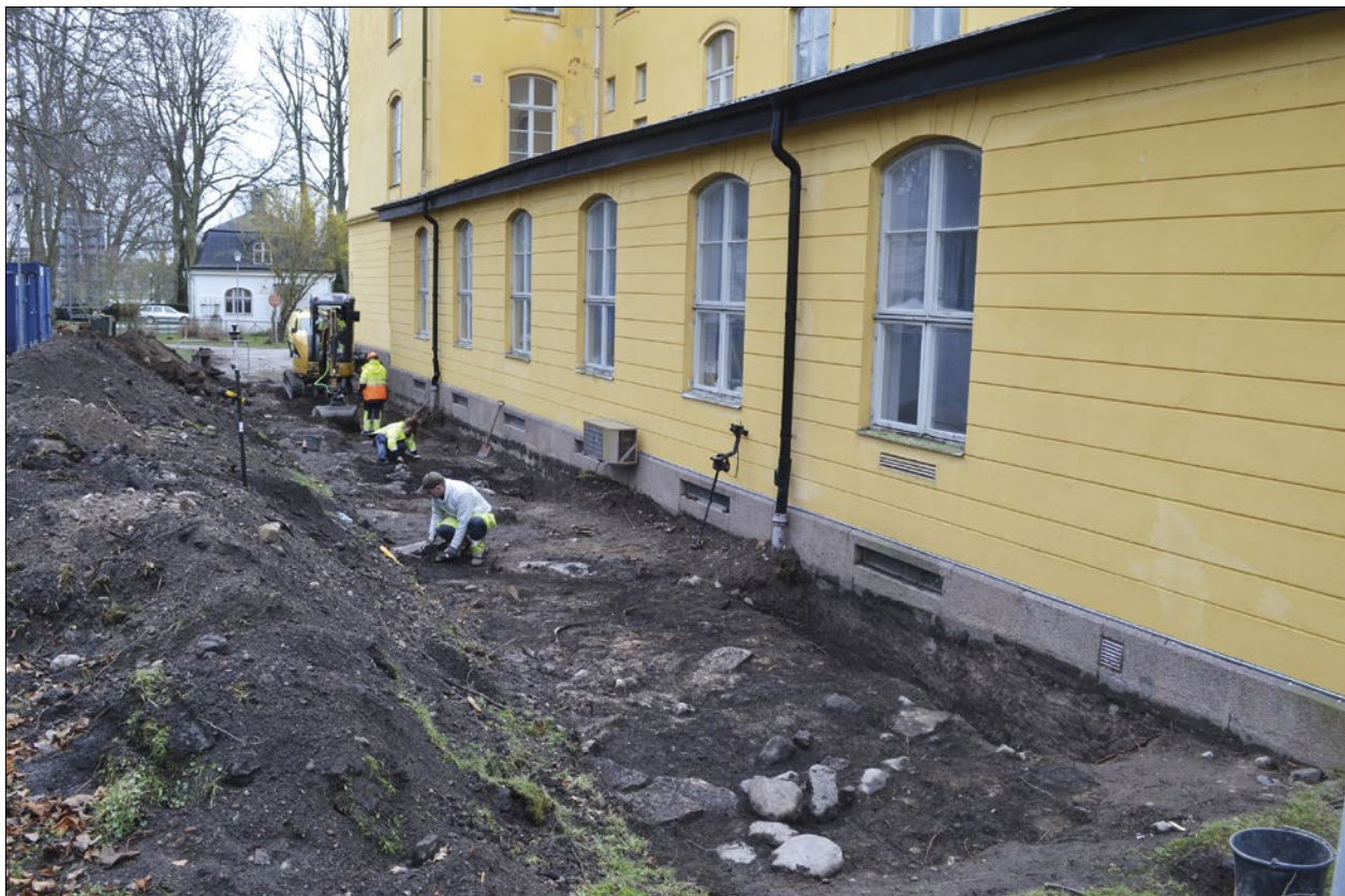
Figur 38. Översikt över dräneringsschaktet längs med fd konstmuseets norra sida, "ingrepp 1".
