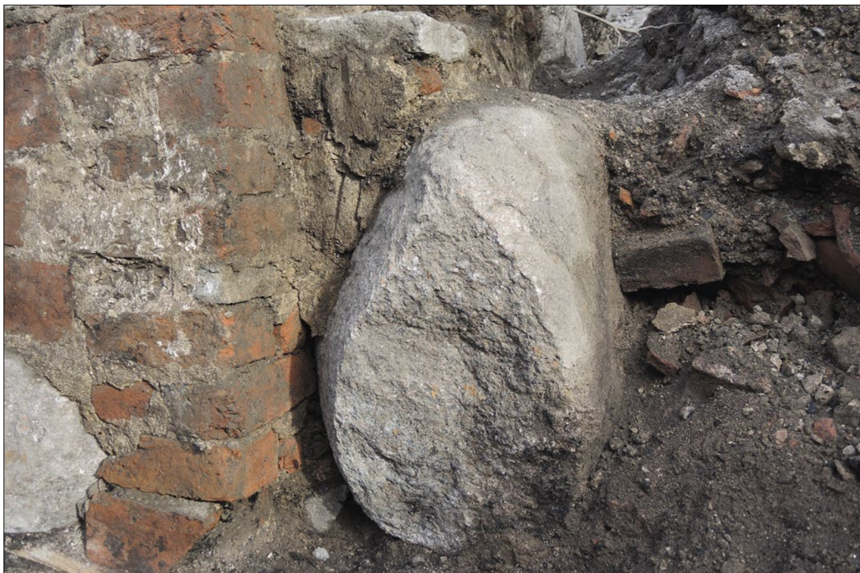
Figur 96 . En stor sten i den ursprungliga konstruktionspackningen som fått huggas till för dörröppning 649 i samband med att Byggnad F:s sydöstra källare uppförts sekundärt.
