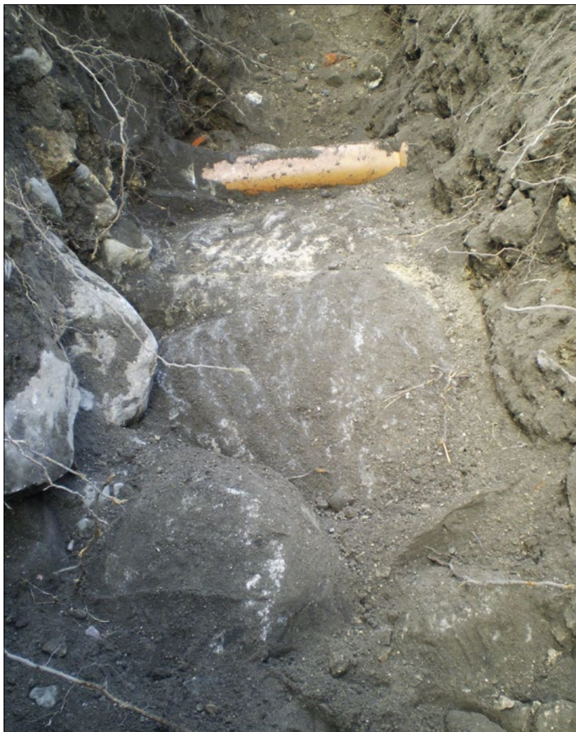
Figur 112. En äldre VA-ledning är anlagd direkt på den avröjda grundmuren 625.
