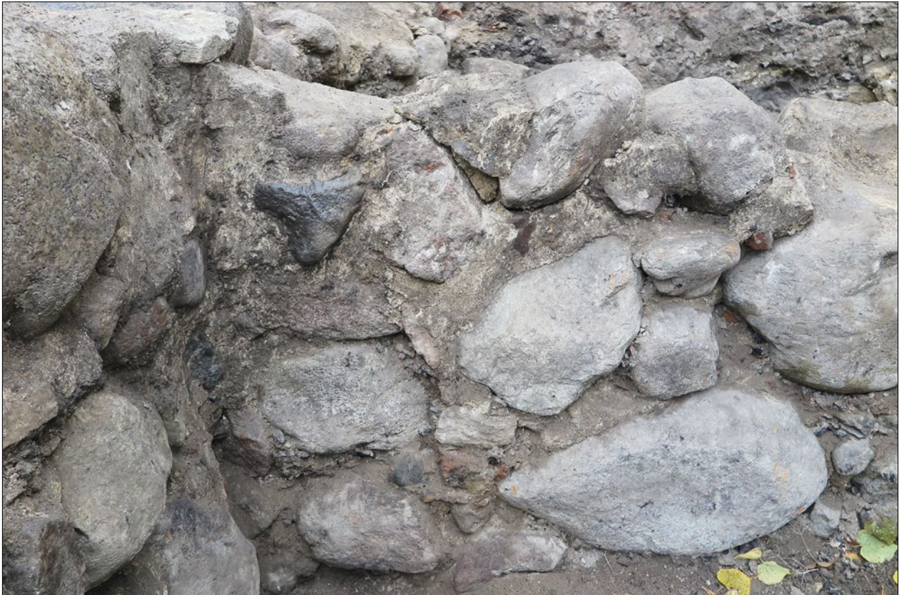
Figur 97. Norra väggen 652=714 i den sydöstra källaren. Murverket ger ett grövre intryck än övriga delar av byggnad F.
