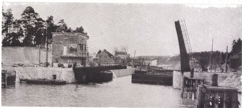
SÖDERTÄLJE KANALS OMBYGGNAD INFÖR SIN AVSLUTNING. Södra slussporten och manöverornet. (Foto. Sorbon, Södertälje). — Kliché: Gots. Öbg.
