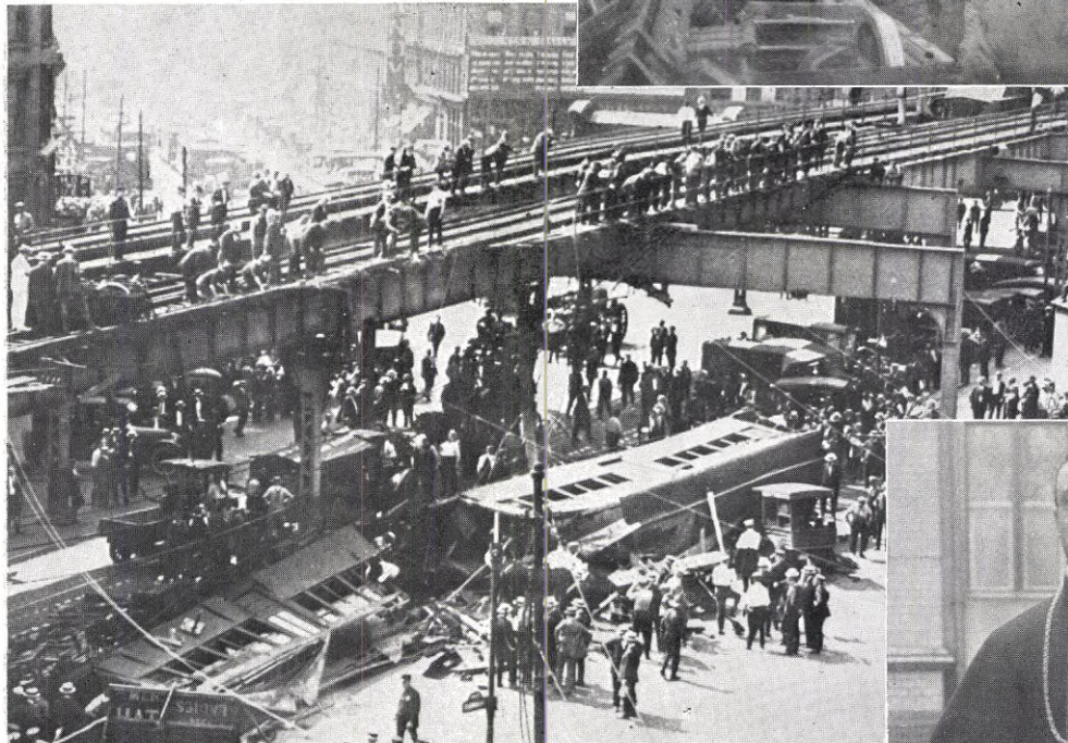
ÖVERJORDSBANA I BROOKLYN STÖRTAR NED på en starkt trafikerad plats den 25 juni, varvid sex personer dödades och 70 sårades. Anledningen till olyckan förmodas vara en axel å första vagnen som bröts. Efter fotografi.
