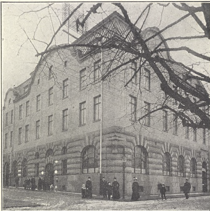
Foto. Lundbäck, Uddevalla. UDDEVALLA SPARBANKS NYA BYGGNAD.
