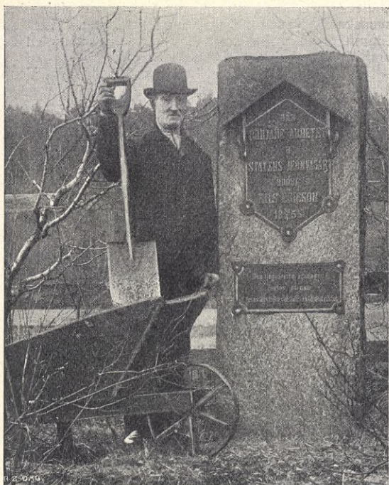
DEN PLATS, DÄR DET FÖRSTA SPADTAGET Å SVERIGES JÄRNVÄGAR TOGS FÖR 50 ÅR SEDAN.
