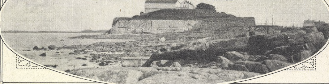
VARBERGS FÄSTNING. — FOTO. HARTMAN, GÖTEBORG.
