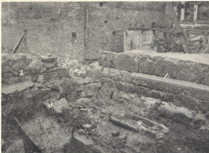
Efter fotograf. Under nu pågående gräfnings vid V. MÅRTENSGATAN I LUND ha påträffats rester af den GAMLA MEDELTIDSKYRKAN "SANCTA MARIA MINOR". Å vår bild synes af utgräfningsarne: Södra kyrkomuren (1), Vapenhusets östra mur (2), Dräneringstrumma, antagligen för afledande af likvatten (3), samt en tegelgraf (4).
