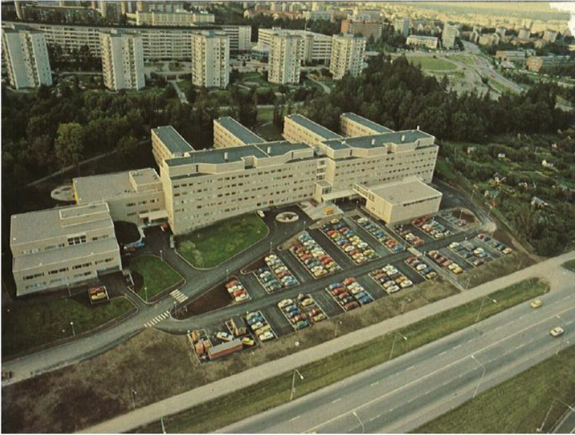
Figur 1. Arbetarskyddsstyrelsens byggnad i Solna, färdigställd 1979.
