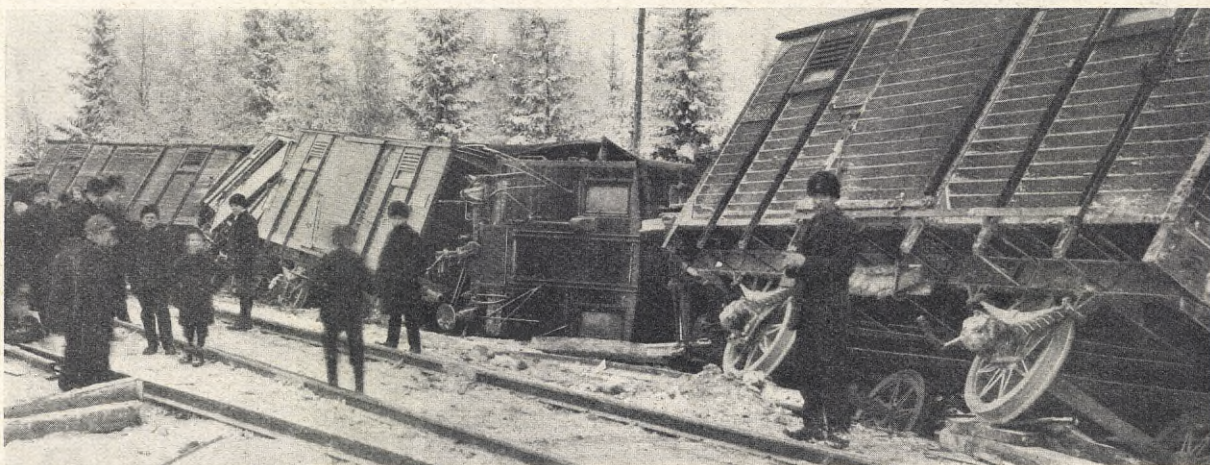
Klitché: Kem. A.-B. Dejnt Sjöfvergarre, Sthlm. Öbg. JÄRNVÄGS OLYCKAN Å SÖDRA STAMBANAN DEN 27 JANUARI: Vy af olycksplatsen.
