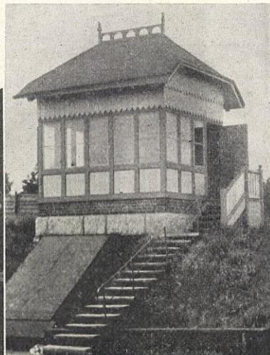
Kliché: Bengt Silfversparre. STÄLLVERKSHUSET VID MALMSLÄTT'S STATION därifrån växlarne omlägges.
