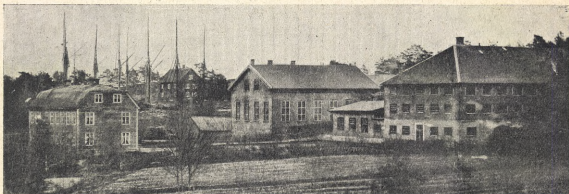
FÖRSTA ANLÄGGNINGEN (boningshus t. v., verkstadsbyggnad och gjuteri t. h.). Foto. 1861.
