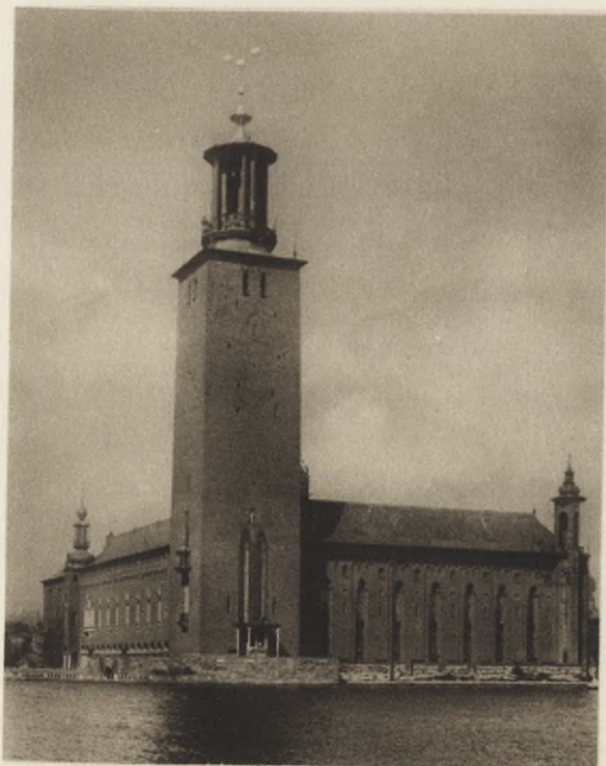
Fig. 71. Stockholms stadshus. Uppfört av Ragnar Östberg. Färdigt 1923.
