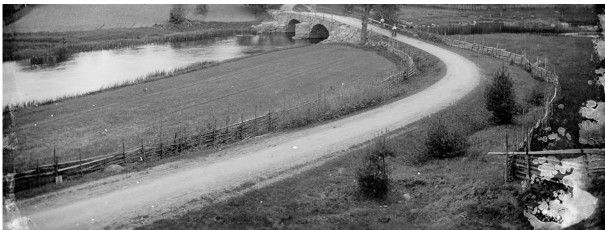
Fig. 22. "Värsås". Horisontellt liggande gärdsel. Lutande störpar. Bindningar är svårt att se. Bilden är beskuren (Bild 3).
