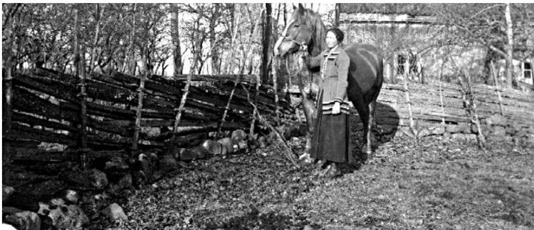
Fig. 20. "Ekby I". Ser ut att vara i gott skick men överligger/överstörning och de lutande störpären pekar på att gärdesgården stått så pass länge att den är i behov av reparation och därför ingår i kategorin tidig medelålder. Bilden är beskuren (Bild 6).
