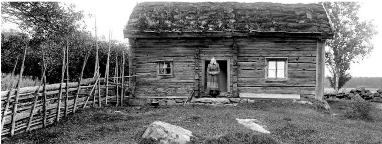
Fig. 31. "Okänd II". Horisontellt liggande gärdsel. Överstörningar. Bindningar saknas nedtill. Lutande störrpar. Bilden är beskuren (Bild 21).
