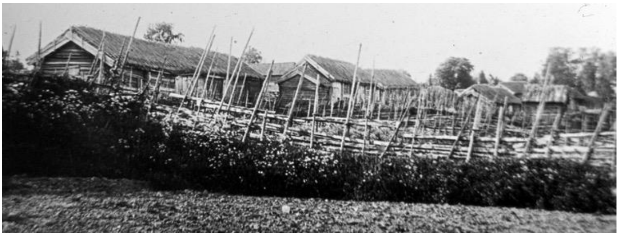
Fig. 30. "Fålebergs by". Horisontellt liggande gärdsel. Flera överstörningar med extra störrpar tyder på kontinuerliga reparationsinsatser. Bilden är beskuren (Bild 19).
