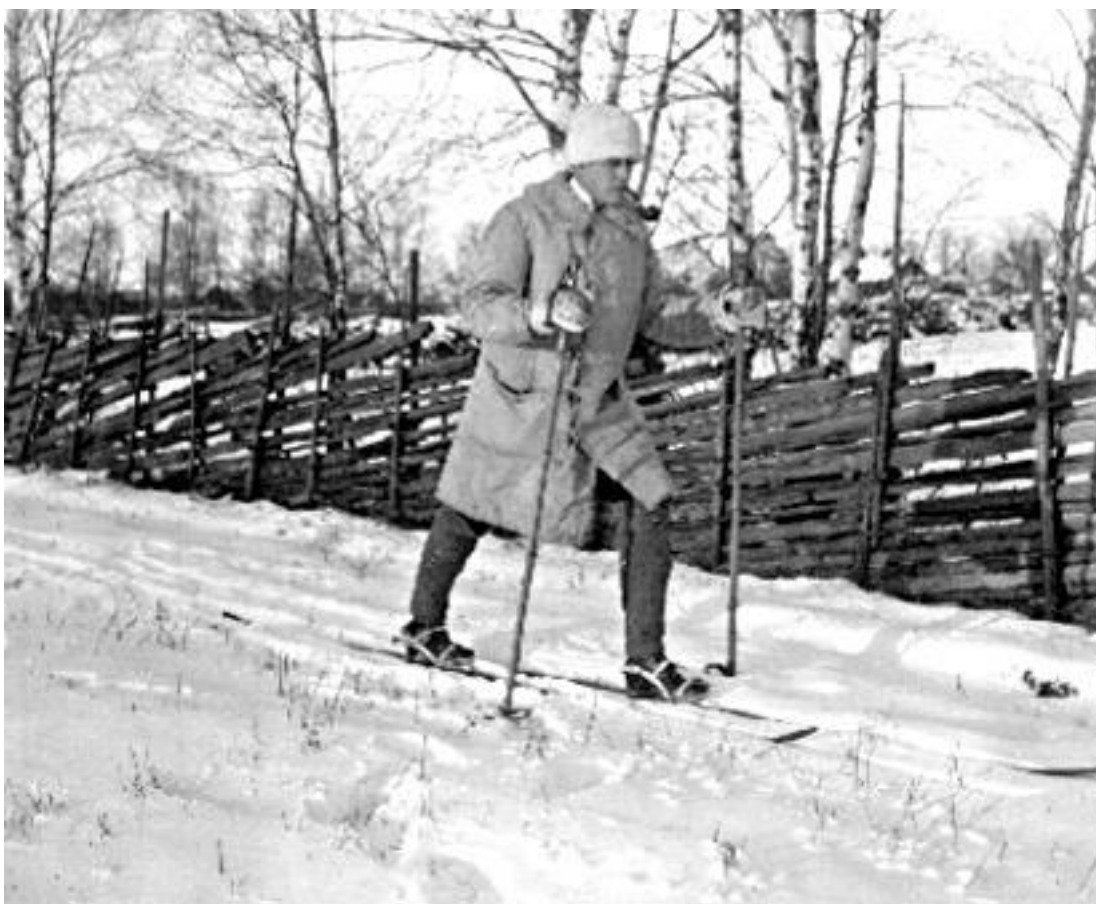
Fig. 11. "Ekby 2". Ung gärdesgård, långlagd med bidningar i jämna intervall. Inga synliga lagningar (Bild 7).
