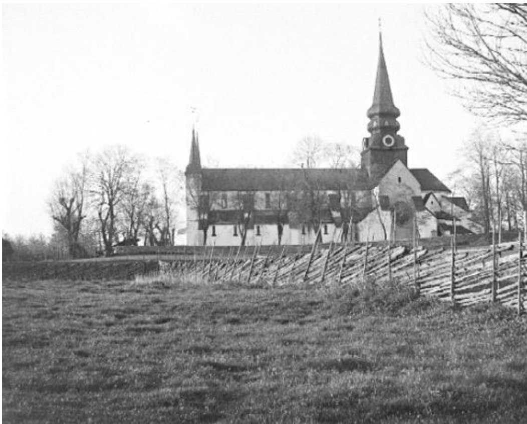
Fig. 18. "Varnhems klosterkyrka". Gärdesgården ser ut att vara i bra skick, relativt jämn, utan lagningar. Men den lutar utåt i mitten av bilden vilket pekar på att den är i behov av uppstöttnings och reparation. Därför antas den ingå i kategorin tidig medelålder. Bilden är beskuren (Bild 2).
