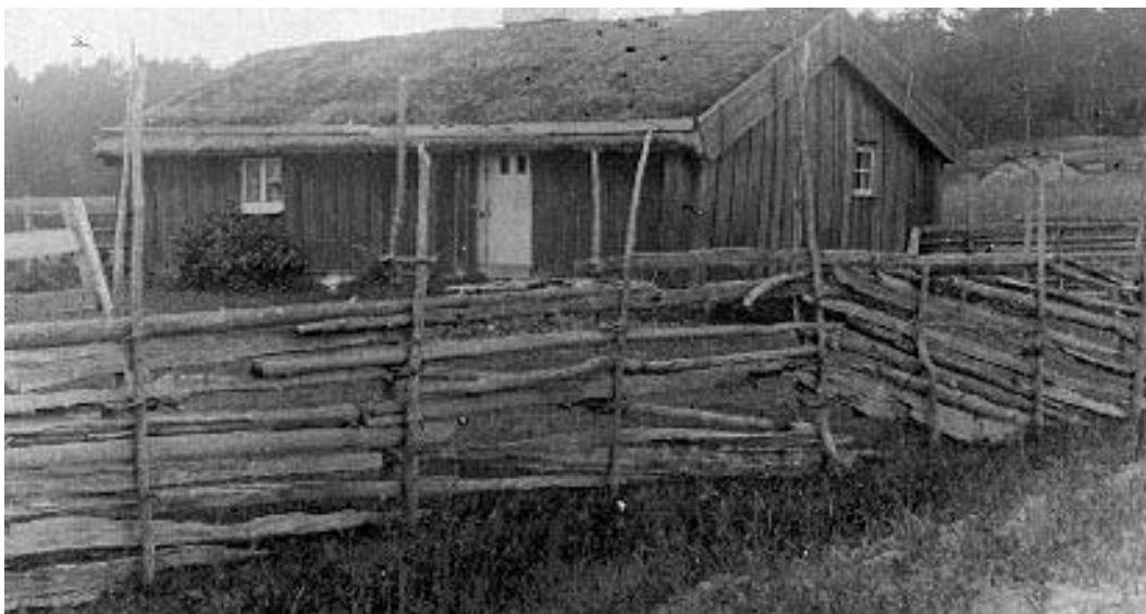
Fig. 21. "Otterstad. Torpet Spiken", kortlagd konstruktion 14a, till höger. Tidig medelålder. Relativt jämn men överstörad en gång och saknar lite bindningar nertill. Bilden är beskuren (Bild 14).
