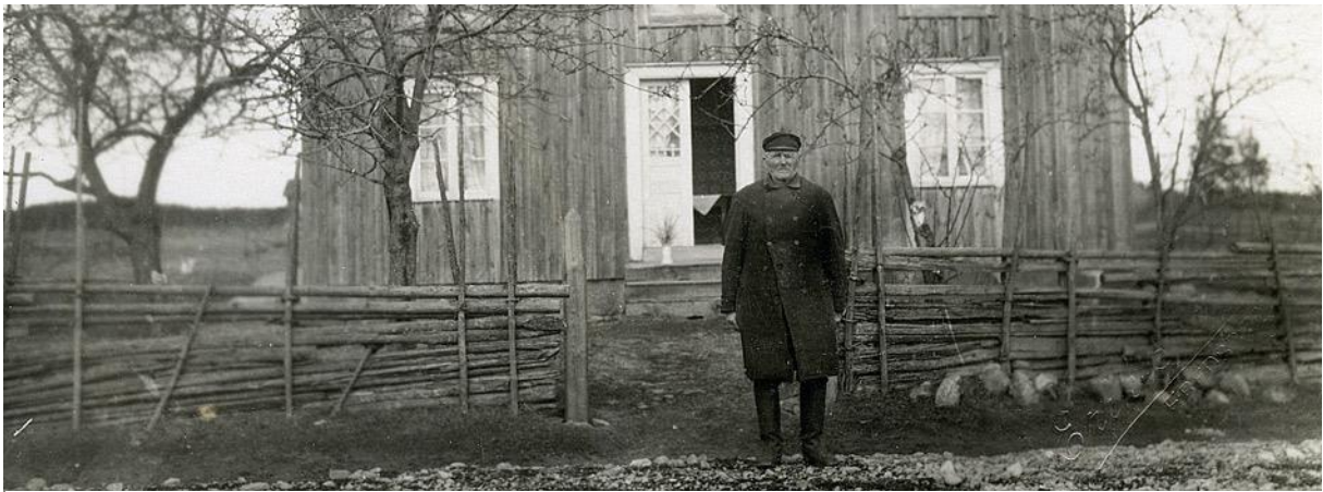
Fig. 29. "Fredsborg". Horisontellt liggande gärdsel. Lutande störrpar. Få bindningar. Överstörningar. Alltsammans tyder på att konstruktionen är gammal. Bilden är beskuren (Bild 16).
