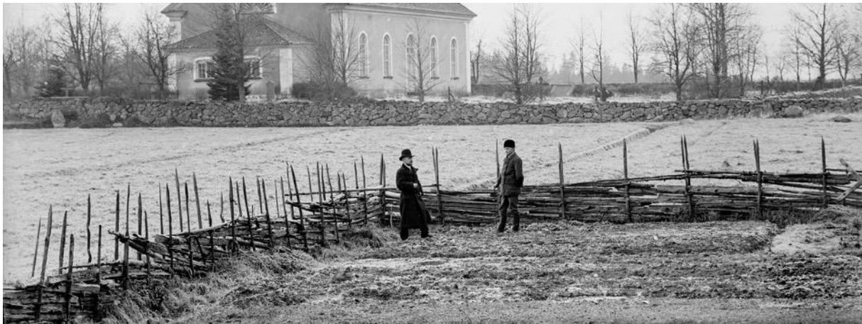
Fig. 19. "Fröjered". Stora partier horisontellt liggande gärdsel borde tyda på att gärdesgården är gammal men pga att hank syns i alla skikten, i konstruktionen rakt fram i bild, kan den istället jämföras med konstruktionerna i bild 18 och 20 som är nya/unga. Överstörningar eller reparationer syns över hela sträckan. Konstruktionen är svårbedömd. Bilden är beskuren (Bild 4).
