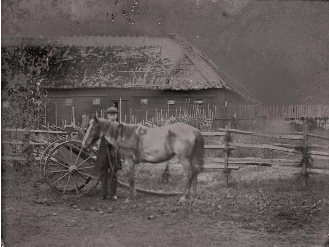
Fig. 14. "Veterinärinrättningen i Skara". Kortlagd konstruktion, löper runt byggnaden. Mellanrum finns mellan gärdslena vilket betyder att bindningar troligtvis finns kvar. Inga synliga lagningar (Bild 13).
