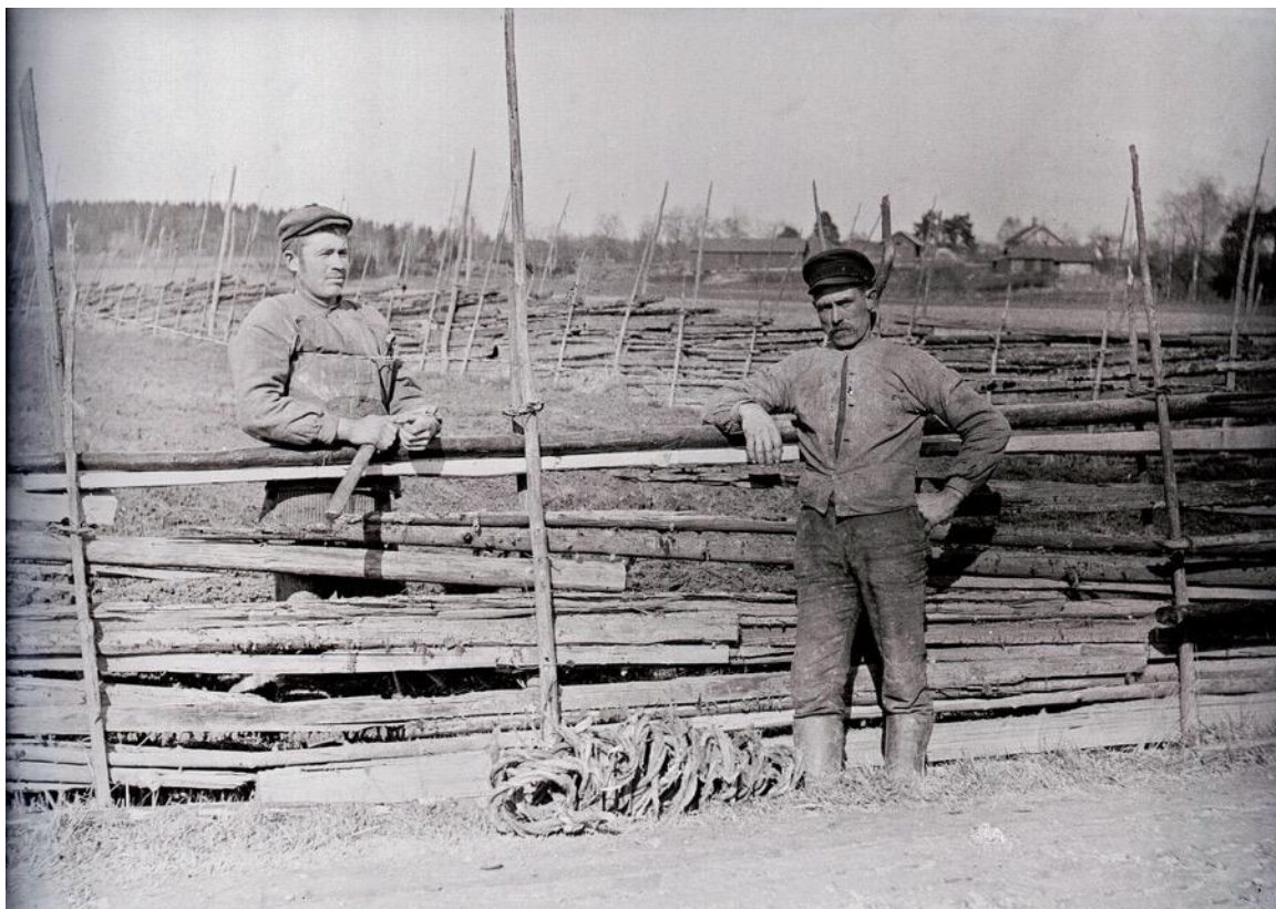
Fig. 37. "Lyrestad". Förproducerad hank ligger på marken. Järntråd/snöre löper under armen på mannen. Avbitartång syns i bröstfickan (Bild 5).
