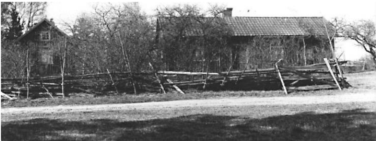
Fig. 26. "Korsberga". Det allmänna skicket talar för att gärdesgården är gammal. Det är oklart hur länge den stått oanvänd. Väder och vind kan delvis ha påverkat men överstörningar syns, ett stöd åt vänster och grova hank syns men de är ojämnt fördelade. Bilden är beskuren (Bild 12).
