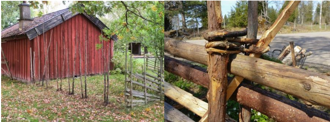
Fig. 4. Till vänster har störrpar satts upp. Till höger: ett stöd har bundits fast i ett störrpar vid nystängning. © Elin Nordlinder
