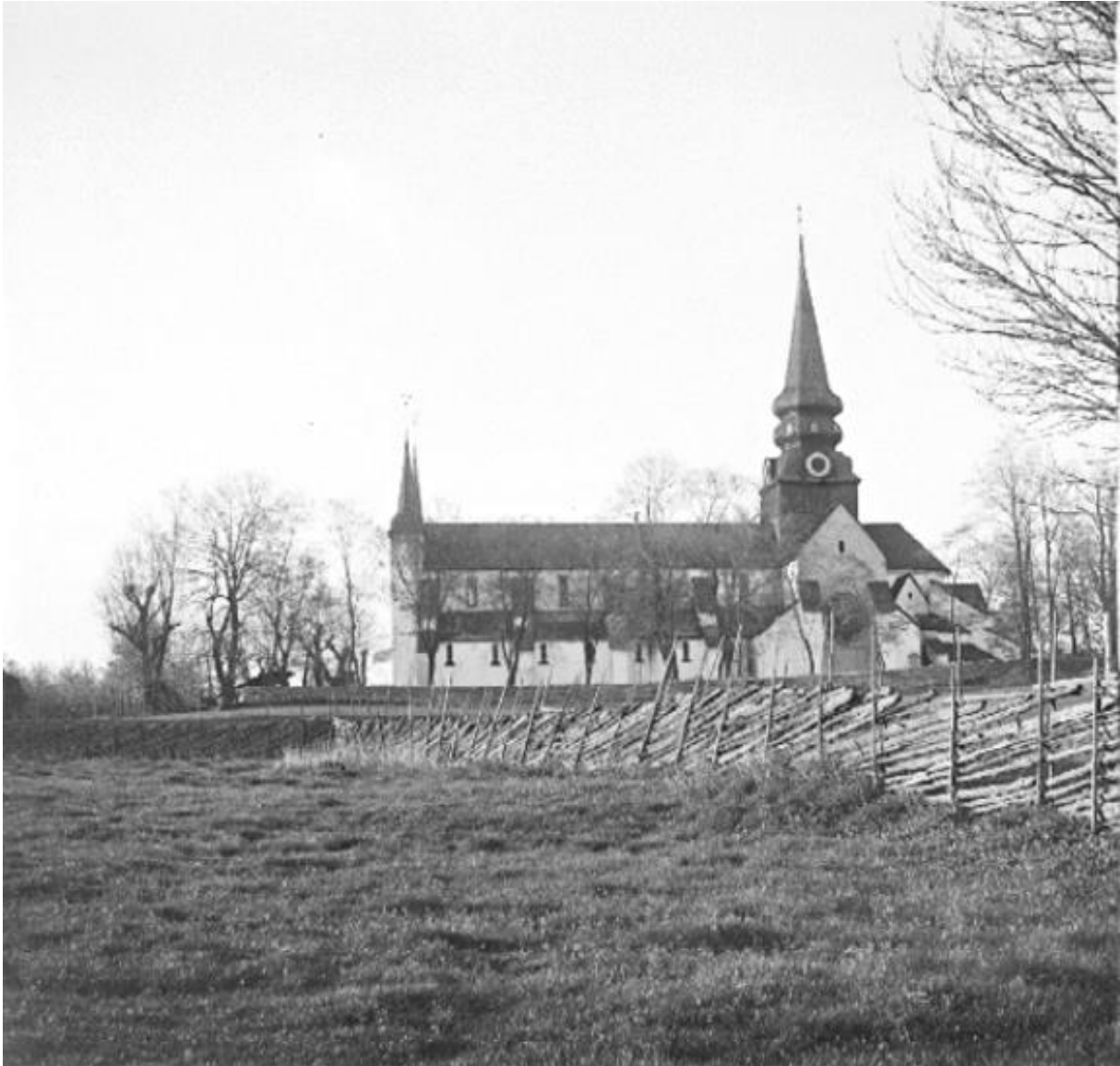
Fig. 6. "Varnhems klosterkyrka". Odaterad. Inga synliga lagningar men konstruktionen lutar utåt i mitten av bilden vilket tyder på att den inte är nystängd (Bild 2).
