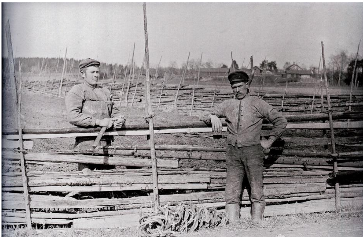
Fig. 23. "Lyrestad". Horisontellt liggande gärdsel. Få bindningar. Överstörning. Sträckan i bildens bakgrund ser ut att vara i bättre skick, dvs. några överstörningar syns ej. Den är dock tät och flack och påminner om de nya/unga konstruktionerna i bild 18 och 20 (Bild 5).
