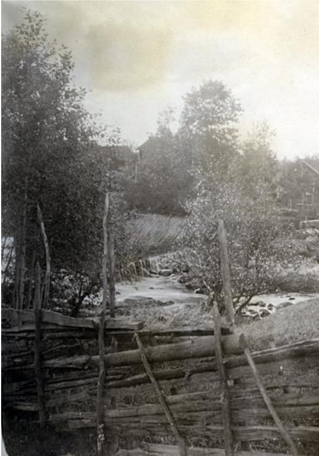
Fig. 9. "Frösve sn. Herrekvarn". Odaterad. Störpar lutar och bindningar syns inte vilket tyder på att gärdesgården stått ett tag. Eventuellt används järntråd/ståltråd som bindning eftersom det finns mellanrum mellan gärdslena på sina håll och störparen har inte ramlat helt (Bild 17).
