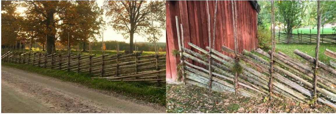
Fig. 2. Långlagd till vänster. Kortlagd till höger. Båda är nyuppsatta.
