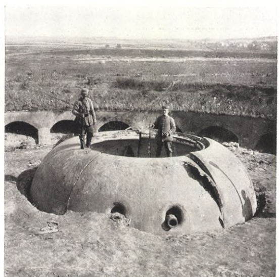
AF TYSKARNES BELÄGRINGSKANONER KROSSADT PANSARTORN i franska fästningen Maubeuge.
