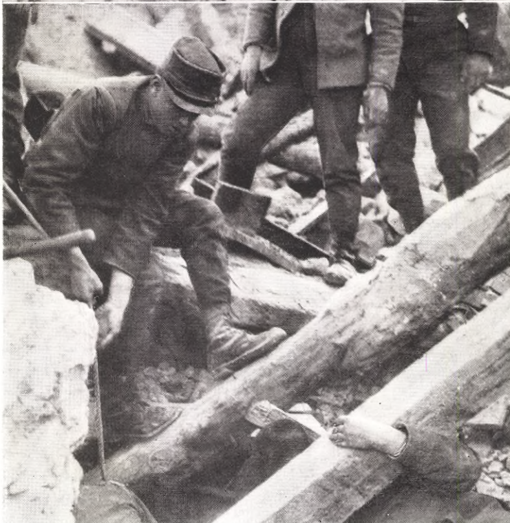
FRÅN SORA. Det svåra och farliga räddningsarbetet. då under rasen begrafna skola framdragas.
