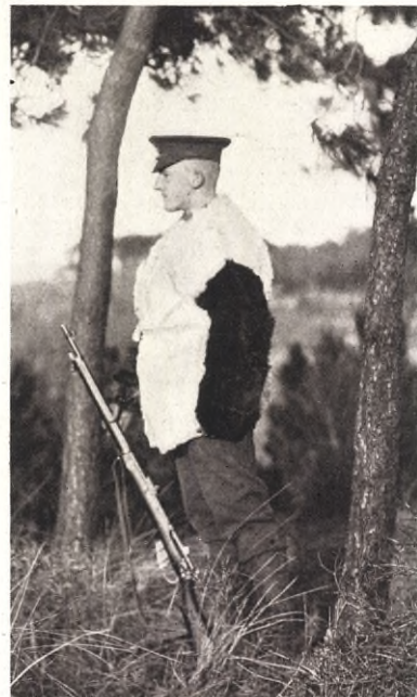
ENGELSK SOLDAT I SIN NYA PALSJACKA på vakt vid fronten
