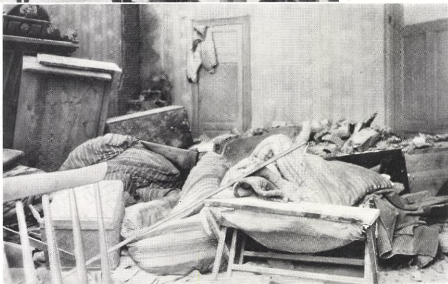
IL 8 De STOCKHOLMSFOTOGRAF. RUM BELÄGET LÄNGST BORT FRÅN EXPLOSIONSPLATSEN. Denna lägenhet förhrydes af två tvätterskor som illa skadades.
