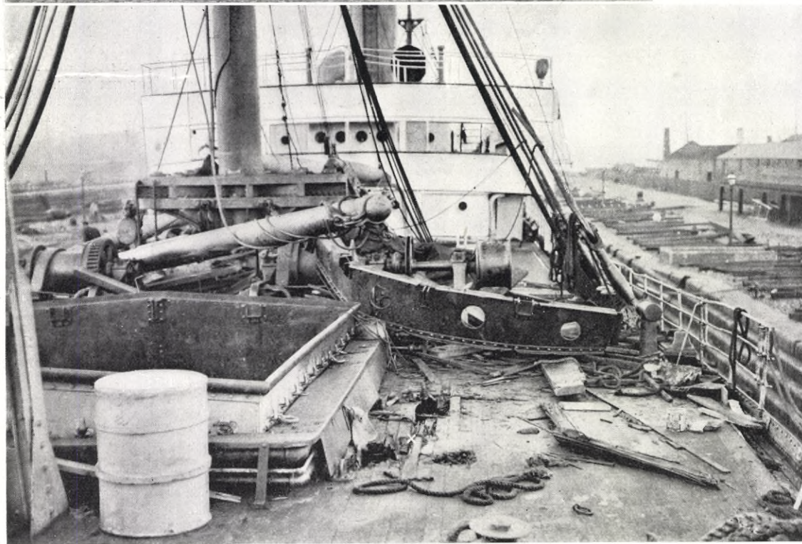
"NEBRASKAN" EFTER TORPEDERINGEN. Däcket med de stora hålen (vid X) efter stycken af torpeden.
