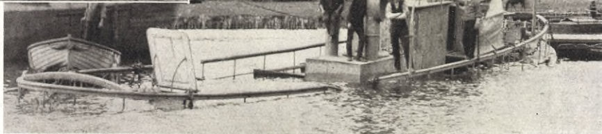
MINKABELBÅTEN N:O 2 EFTER KOLLISIONEN MED ÅNG. "BELE" PÅ RIFÖFJORD. Minkabelbåten under upptagning. Öfverst en bild af den svåra läcka den erhöles vid kollisionen.
